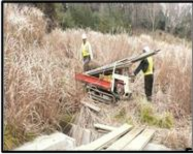
緩斜面搬入状況
