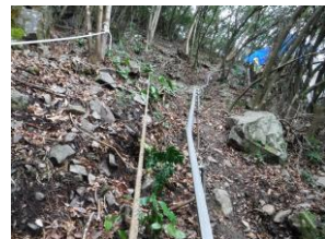
運搬用モノレール架設状況
