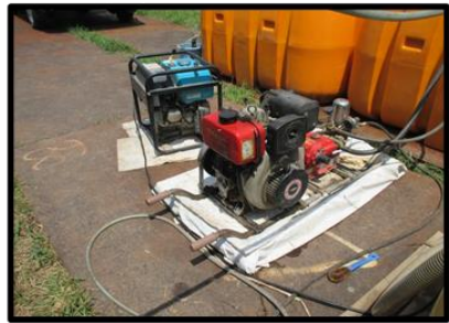
油漏れ防止措置
