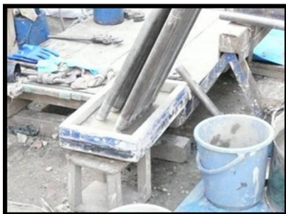
立掛けたロッド内の 泥水滴水飛散防止措置
