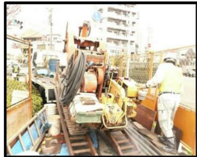
トラックへの積み込み状況
