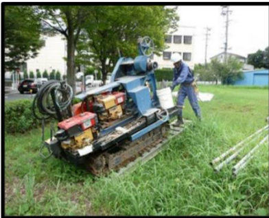
平坦地搬入状況
