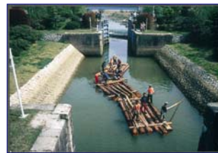
船頭平閘門(1902年完成)
