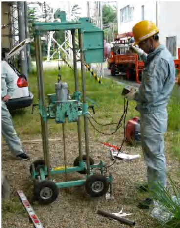
サーチ型地盤調査機(N型)を使用して測定孔を掘削中 (サーチ型地盤調査機は仁平製作所製)
