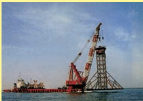
起重機船による運搬
