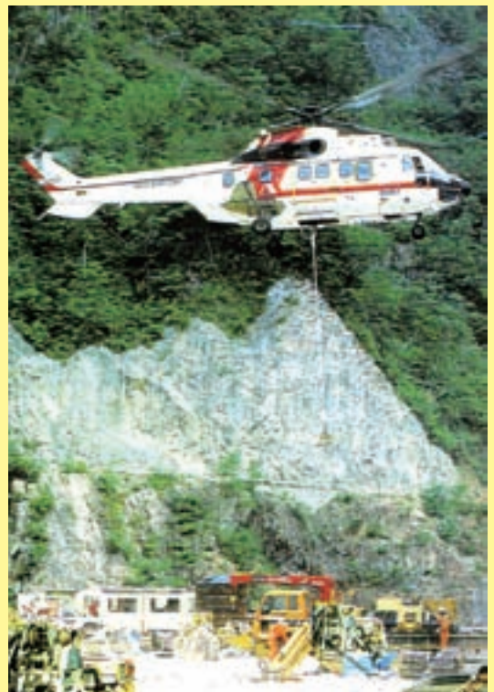
資機材基地（機材積載状況）
