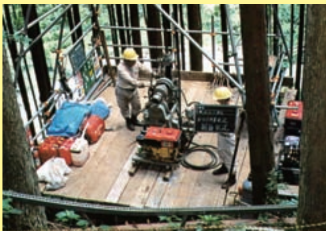
足場上へのボーリングマシン設置
