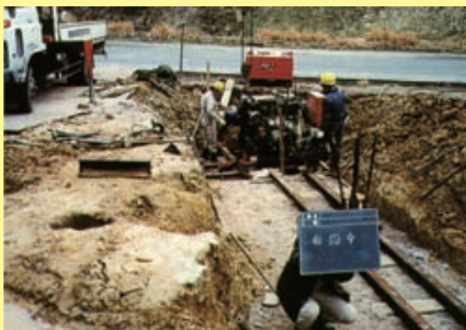
水平ボーリング機械設置
