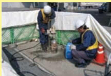
舗装の掘削・復旧（掘削状況）
