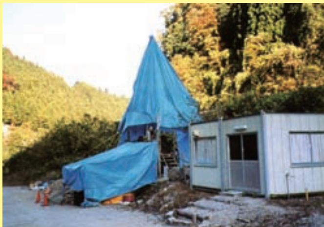
現場基地とボーリング作業
