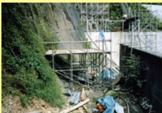
ボーリング作業足場
