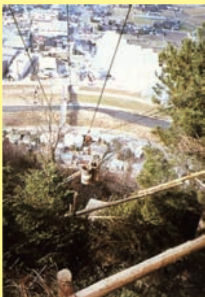
索道による資材運搬
