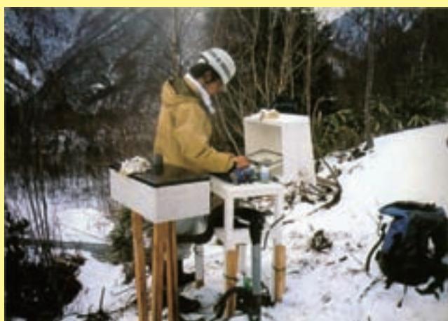
自記式水位計（半自動観測）設置状況
