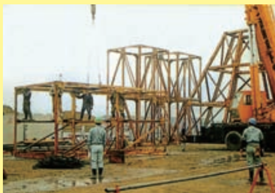
陸上での組立作業
