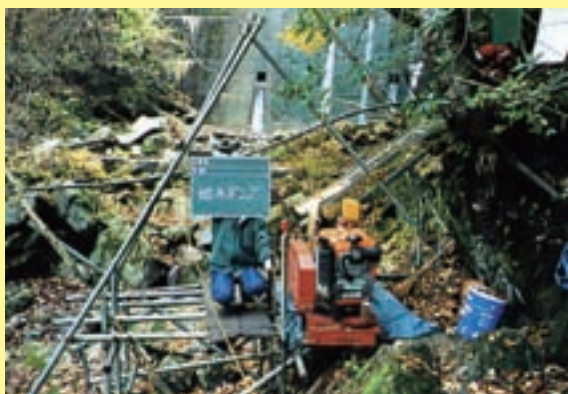
配管給水（給水ポンプ設置状況）仮設
