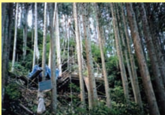
山林内での傾斜地足場
