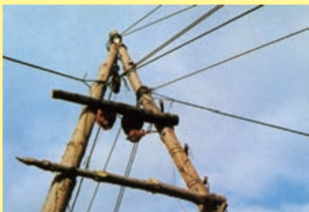
索道仮設（先柱の近景）
