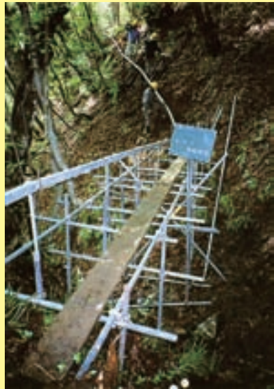
モノレール仮設状況
