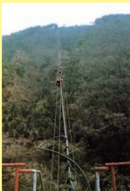
索道仮設（主索設置状況）
