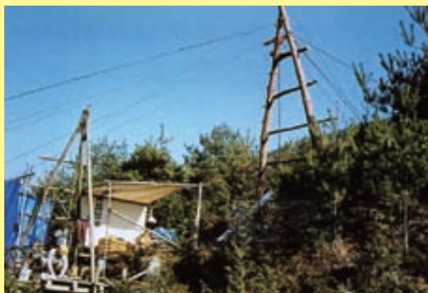
索道仮設（先柱の状況）
