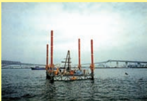
台船上でのボーリング作業
