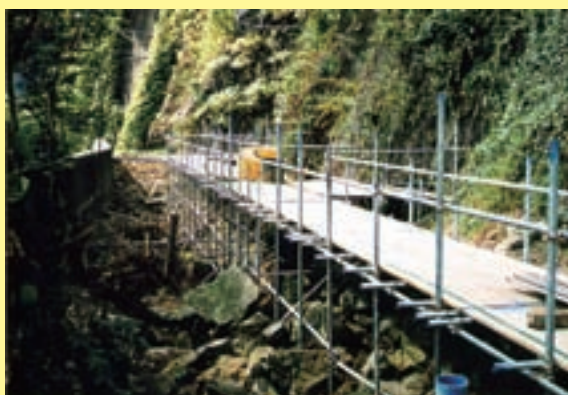
傾斜地における搬入路足場
