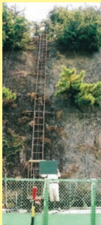
簡易リフト仮設
