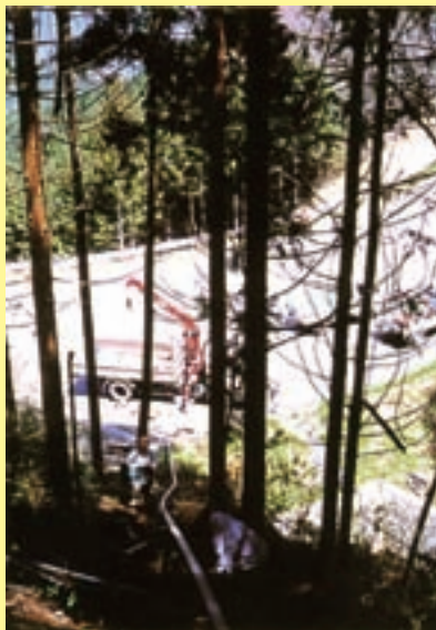
モノレール仮設状況
