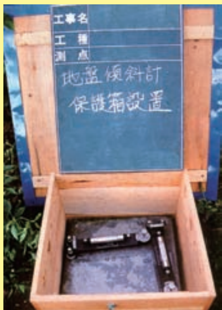
傾斜計設置状況
