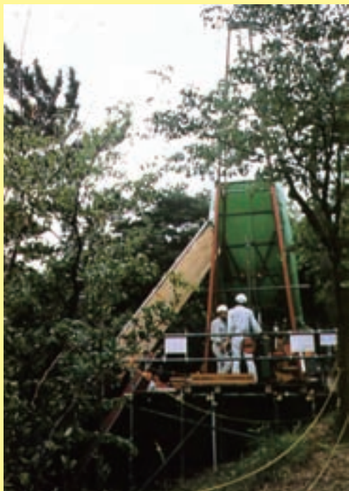
足場上でのボーリング作業状況
