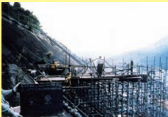
傾斜地での水平ボーリング足場
