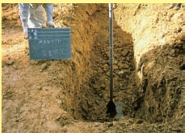
地表面沈下計設置状況
