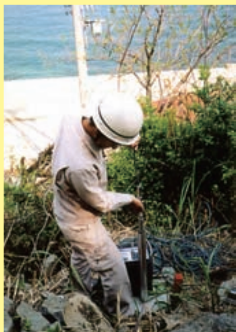
孔内傾斜計観測状況
