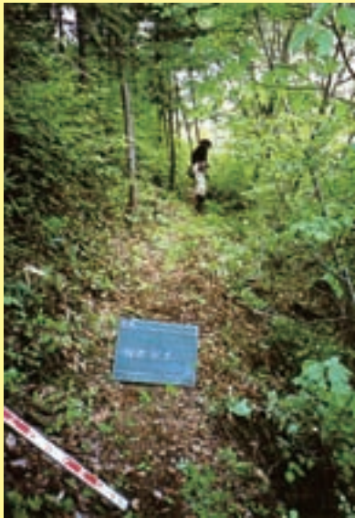
モノレール運搬経路の整備
