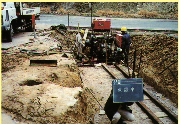
水平ボーリング機械設置
