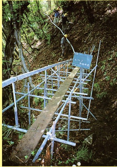
モノレール仮設状況
