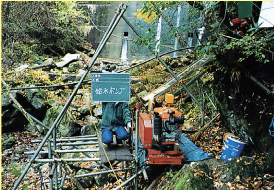
配管給水（給水ポンプ設置状況）仮設
