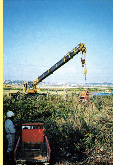
トラッククレーンによるボーリングマシンの積み換え作業
