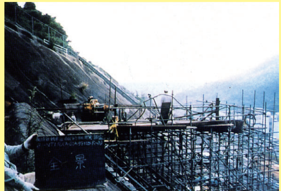
傾斜地での水平ボーリング足場
