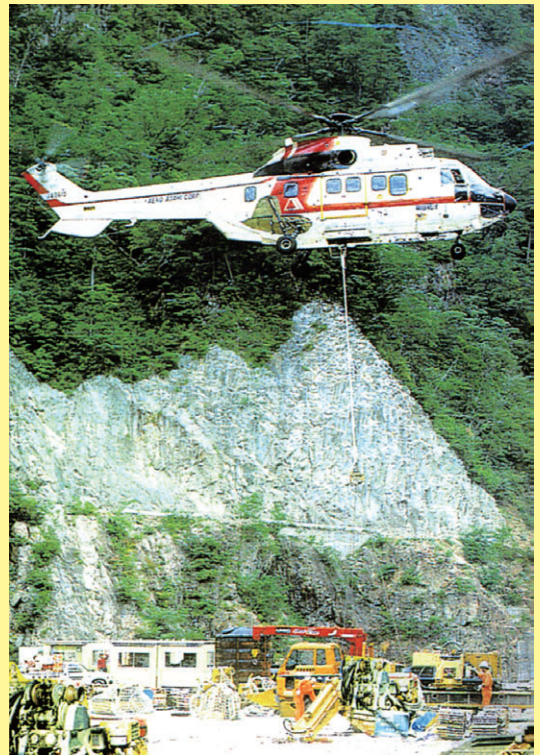
資機材基地（機材積載状況）
