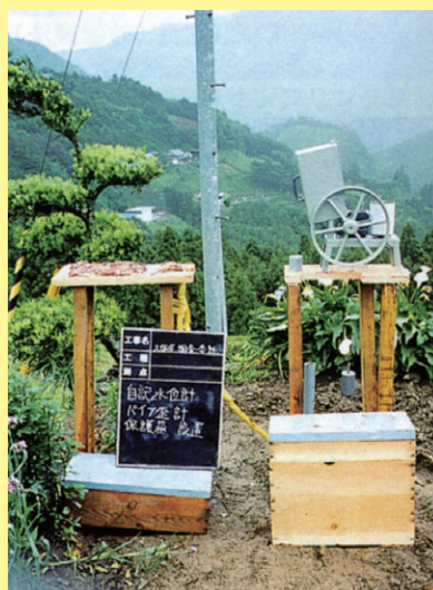
自記式水位計（右）パイプ歪計（左）設置状況
