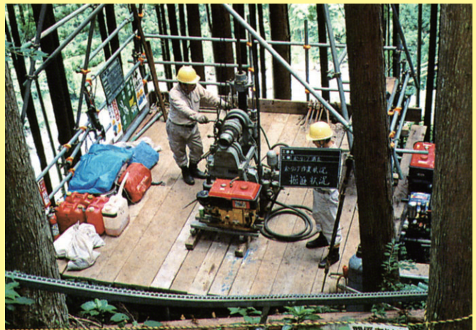
足場上へのボーリングマシン設置
