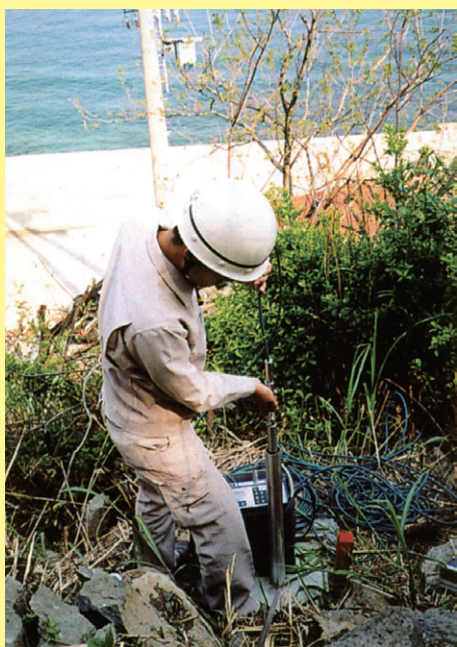
孔内傾斜計観測状況
