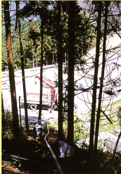
モノレール仮設状況
