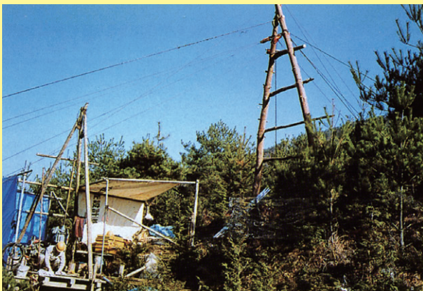
索道仮設（先柱の状況）
