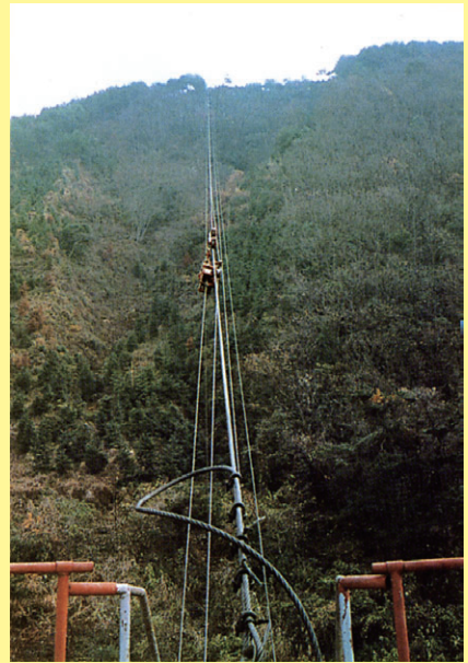
索道仮設（主索設置状況）
