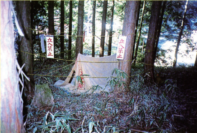
弾性波探査における火工所設置状況
