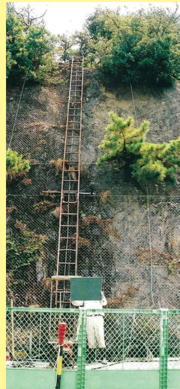
簡易リフト仮設
