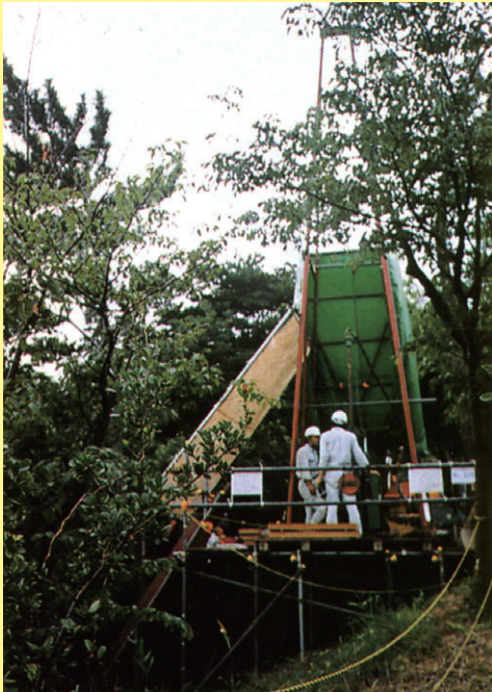
足場上でのボーリング作業状況
