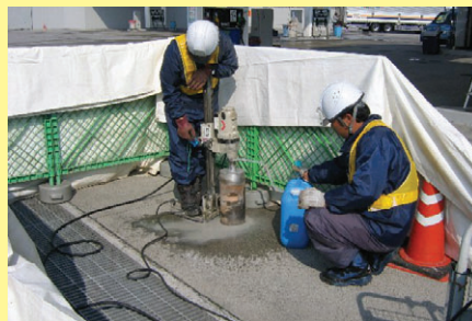
舗装の掘削・復旧（掘削状況）
