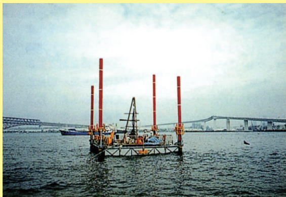
台船上でのボーリング作業
