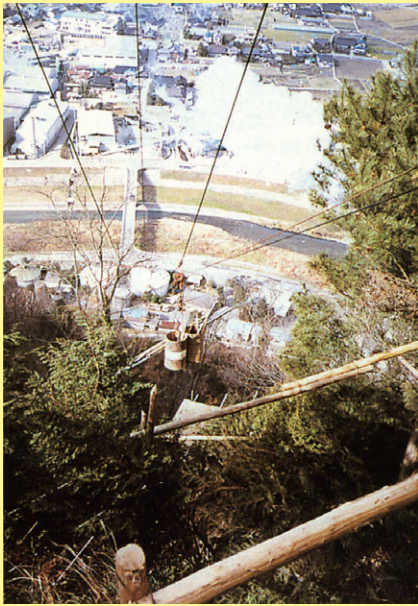
索道による資材運搬
