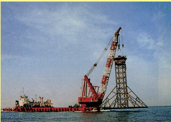
起重機船による運搬
