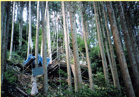
山林内での傾斜地足場
