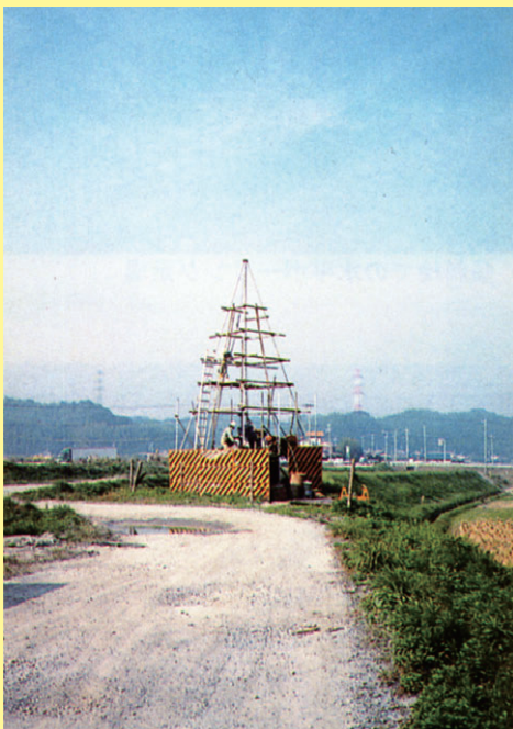
道路近接地でのボーリングマシン設置
