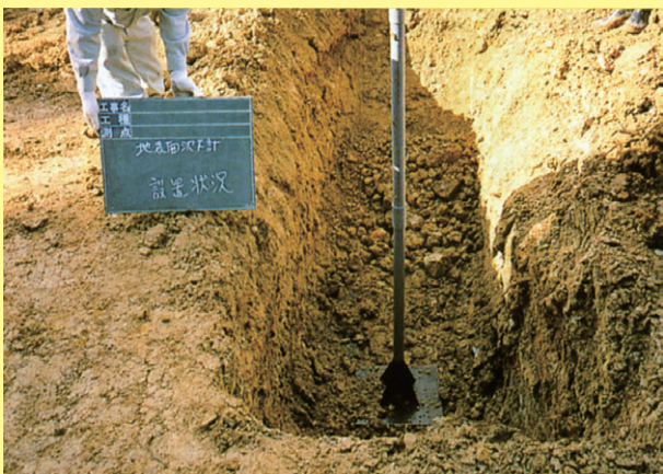
地表面沈下計設置状況
