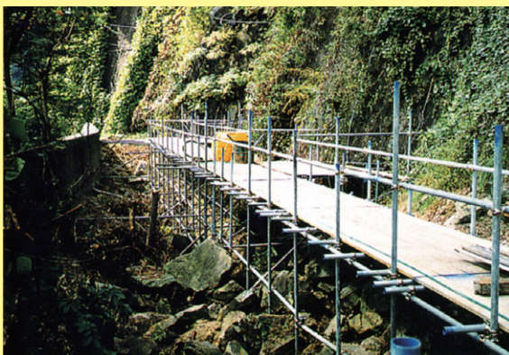
傾斜地における搬入路足場
