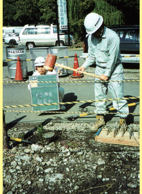
PS検層（板たたき法測定状況）
