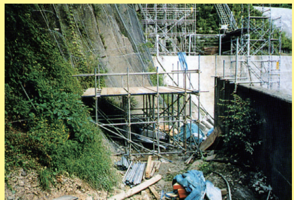
ボーリング作業足場
