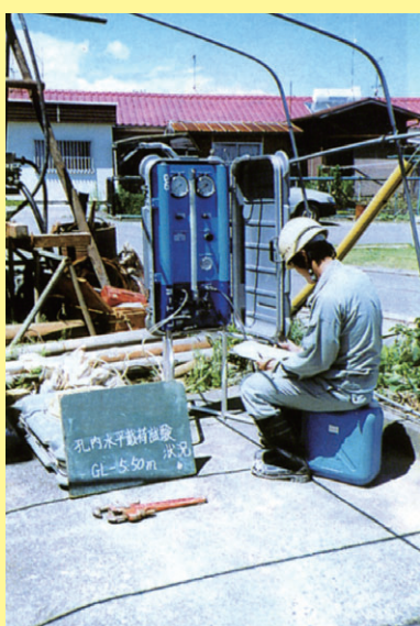
孔内水平荷重試験
