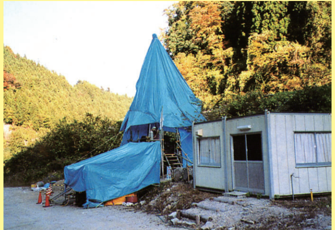
現場基地とボーリング作業
