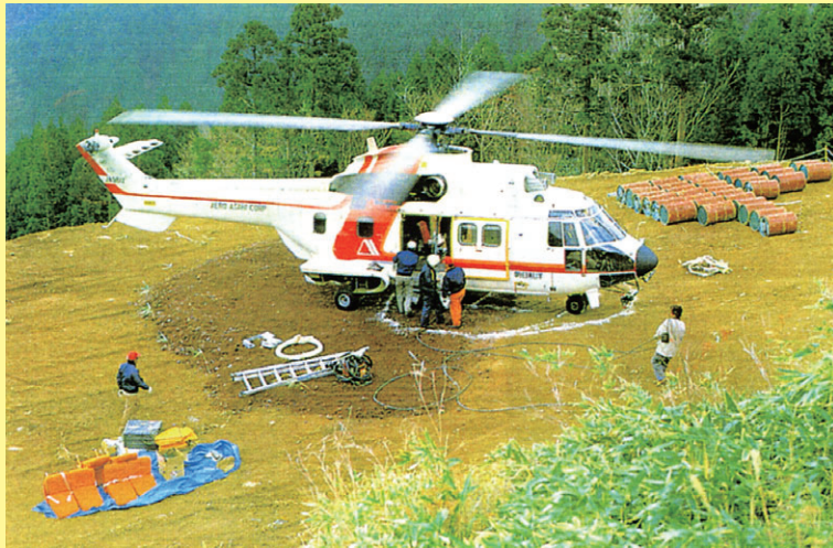
ヘリポート仮設状況
