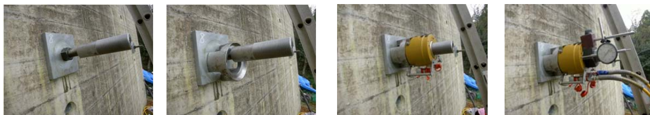
①アタッチメント装置 ②ラムチェアー装置 ③シリンダー装置 ④設置完了
