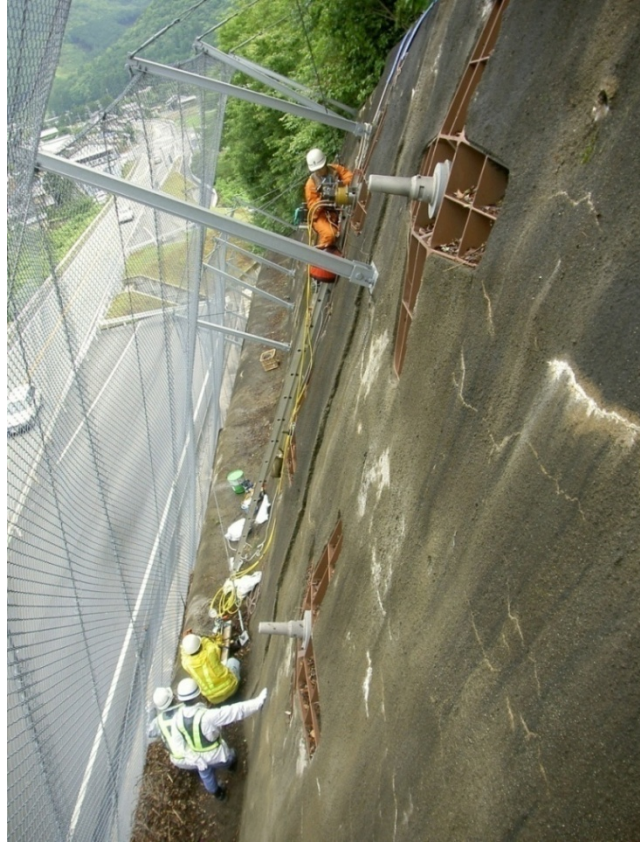
写真-2.1 SAAM ジャッキによるリフトオフ試験状況
