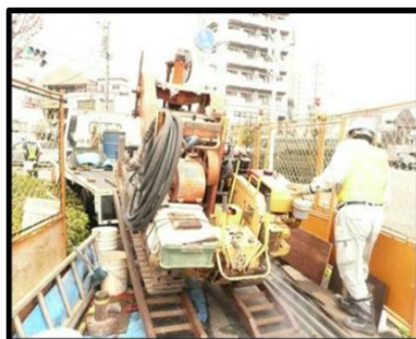
トラックへの積み込み状況
