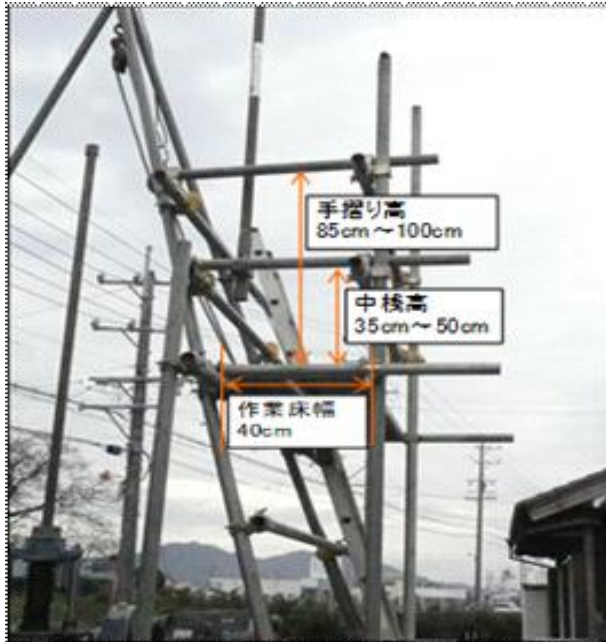
高所作業床 設置例
