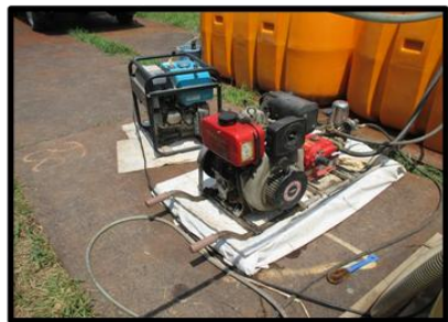
油漏れ防止措置
