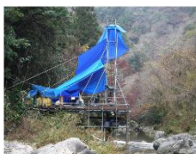
水上 斜面肩足場
