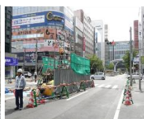
市街地 全足場
