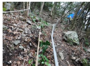
運搬用モノレール架設状況
