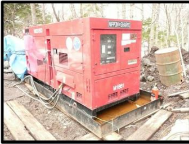
発電機下部への油漏れ防止 措置(オイルパン設置)
