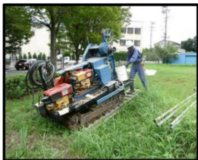
平坦地搬入状況
