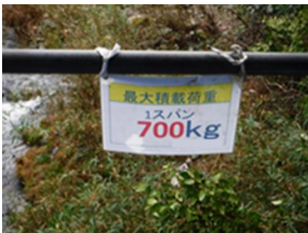
作業構台1スパン最大積載荷重 掲示状況
