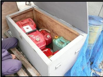
作業現場の燃料缶 保管状況
