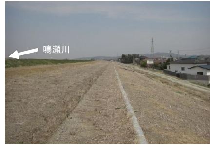
川裏第1小段の状況 (上流側:13.3k付近から, 4/15)
