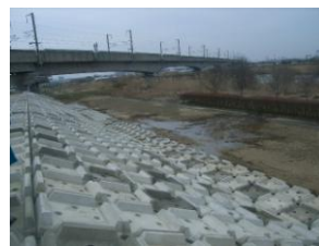
護岸下部からの水のしみ出し (緊急復旧後 4/7)
