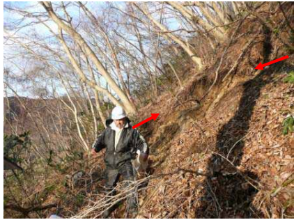
写真12 上部斜面に生じた滑落崖 (赤矢印間)
