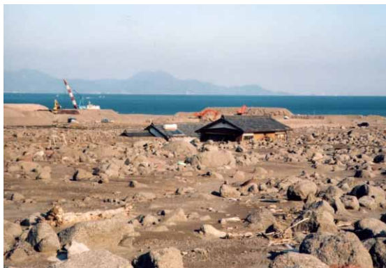
土石流で埋没した家屋
