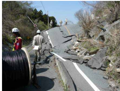
写真18 末端部における路面の隆起
