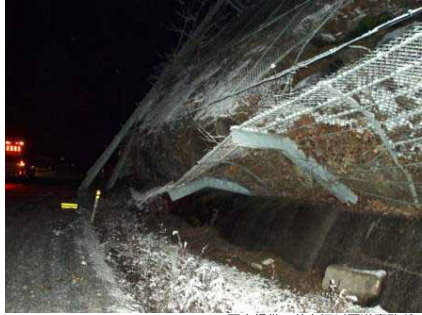
(写真提供：仙台河川国道事務所)
