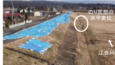
天端の状況(上谷地橋から下流側を望む, 3/16)
