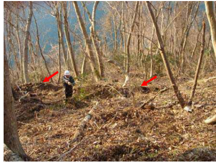
写真13 変状を生じた斜面 赤矢印：斜面内に生じた亀裂
