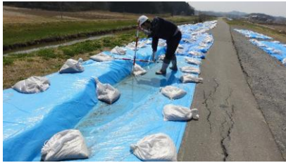
天端の縦断亀裂および段差 (4/15)
