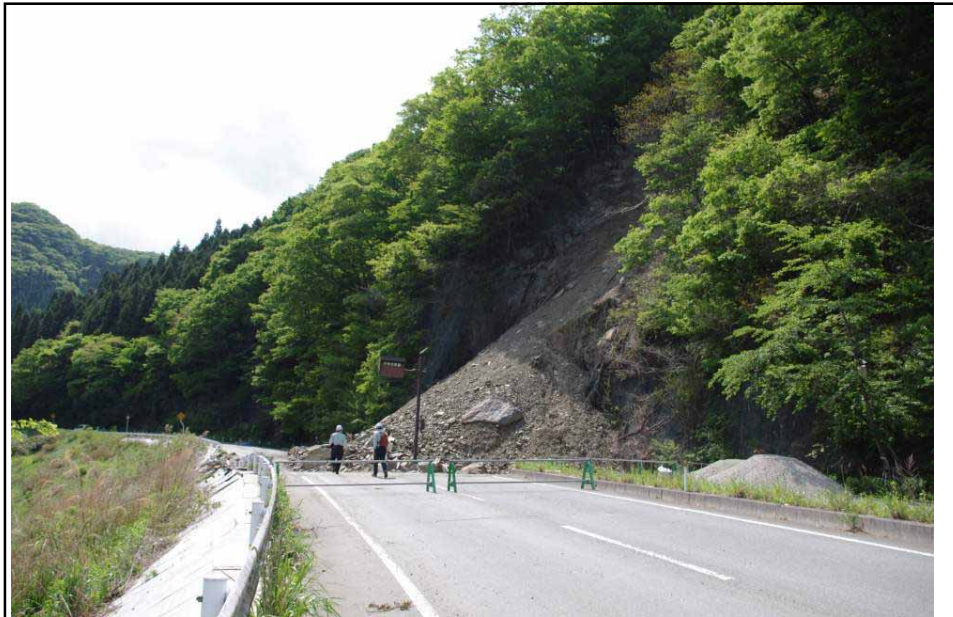
地すべり東側の岩盤崩壊 (地震断層のすぐ西側。ただし崩壊時期は余震より少し後との情報)
