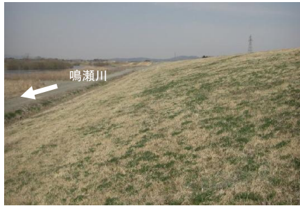
川裏第1小段の状況 (下流側:13.3k付近から, 4/15)
