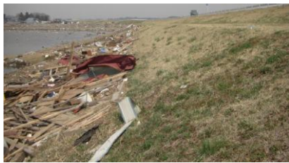
川裏のり尻部の状況 (4/15)
