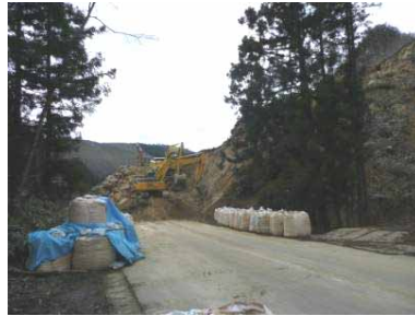
岩手県一関市巖美町下真坂(一般国道397号) 平成20年度災害後1:1.0で切り直した隣接切土のり面が崩壊(落ち残り?) (左写真はH21.6月、右写真はH23.4月)
