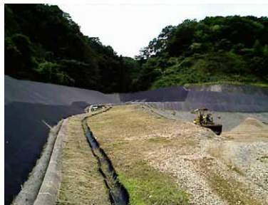
最終処分場の埋立作業
