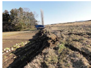
川裏側の耕作地を覆う崩土
