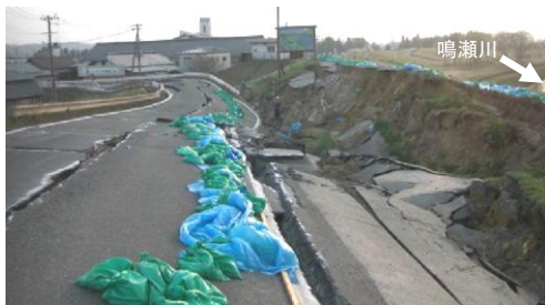
堤防天端～川裏側のり面の状況 (4/15)
