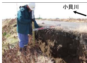
堤防天端の川裏側のり肩部の段差 ※)
