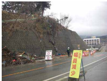
写真33 津波が襲来した切土のり面のコンクリートブロック積擁壁 津波が擁壁の上端を越えたが、擁壁には被災がなかった。
