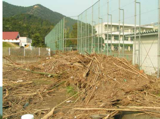
湊川右岸の福栄小学校グラウンド(東かがわ市)
