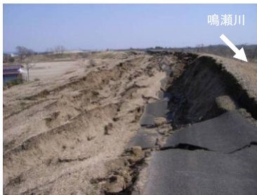
堤防天端~川裏側のり面の状況
