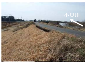
川裏側のり面の亀裂 ※)
