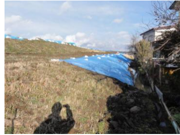
川裏側のり戻の状況 (3/16)
