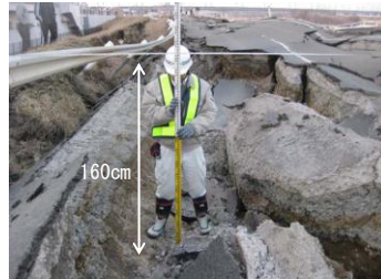
天端(市道兼用堤防)の状況(拡大)(3/17) 2)
