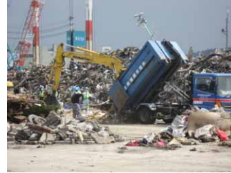
瓦礫除去;仮置き場へ
