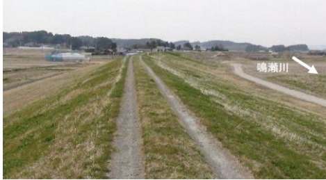
川表～天端～川裏の状況 (4/15)
