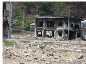
田老町の被災状況2011.06
