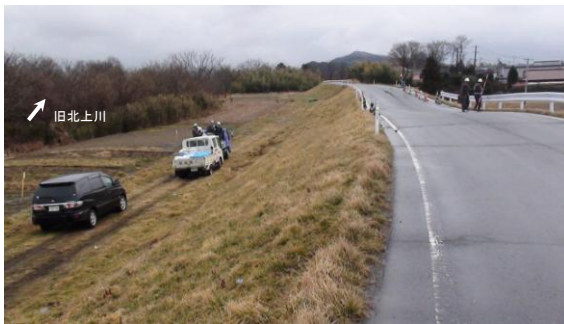
堤防天端の状況 (3/16)
