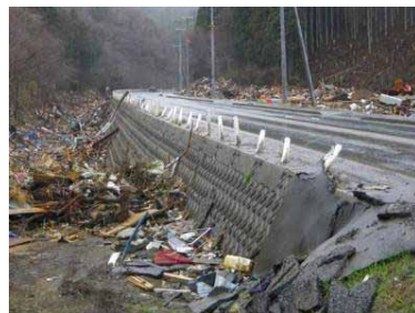
写真34 津波が襲来した道路盛土側面のコンクリートブロック積擁壁 津波が道路面（盛土上面）を越えたが、擁壁には被災がなかった。
