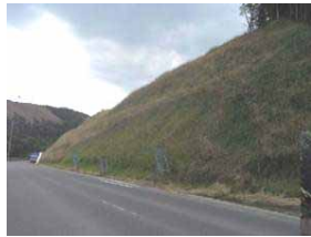
岩手県一関市巖美町下真坂(一般国道397号) 平成20年度災害後1:1.0で切り直した隣接切土のり面が崩壊(落ち残り?) (左写真はH21.6月、右写真はH23.4月)
