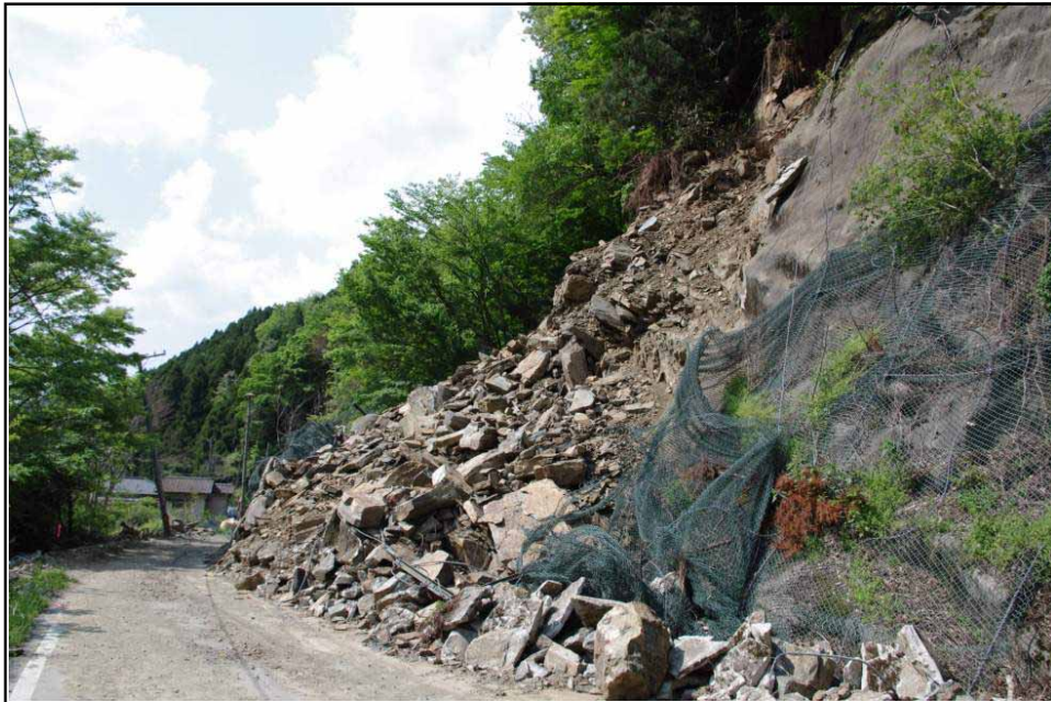
地すべり西側の隣接斜面の岩盤崩壊(トッピング構造が見える)
