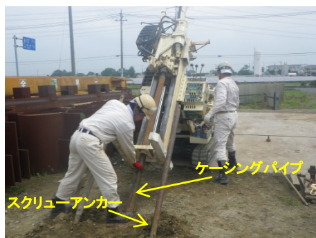
写真-4 ケーシングパイプ設置状況 2)
