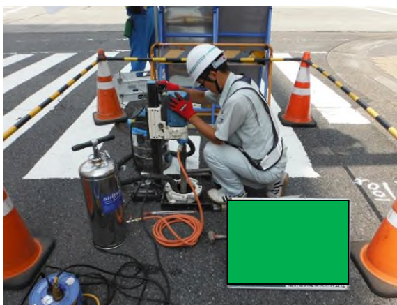
写真 4.6.1 ボーリング削孔 実施状況
