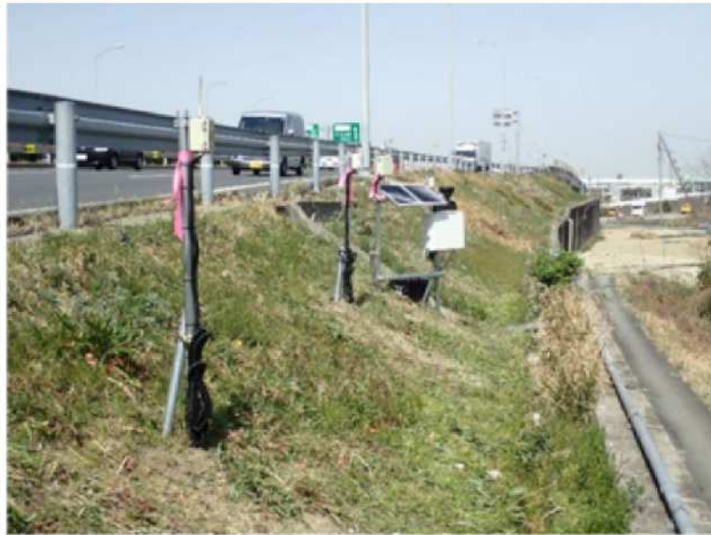
変状が進行した有料道路沿いの法面モニタリング
