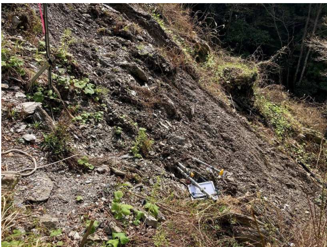
写真3-1 崩壊状況(1) 計器の転倒が認められる
