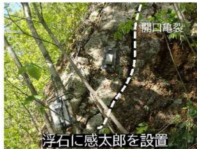
浮石に感太郎を設置
