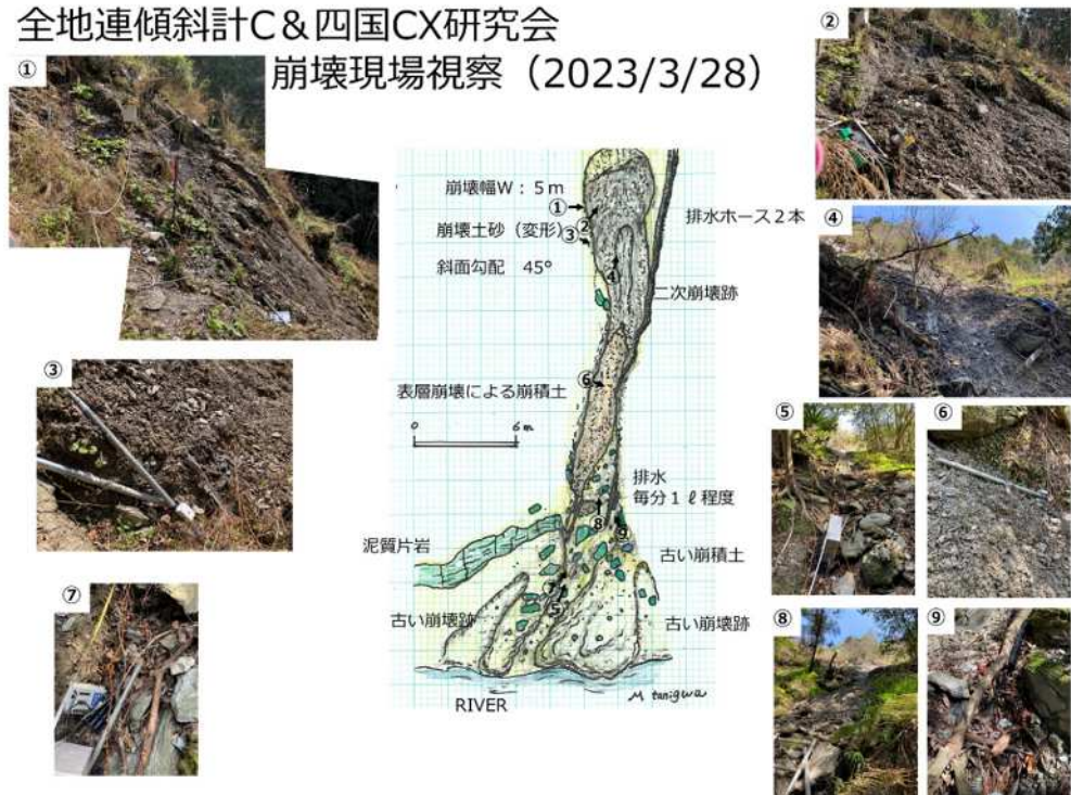
図3-10 崩壊状況 (令和5年3月28日現地視察)
