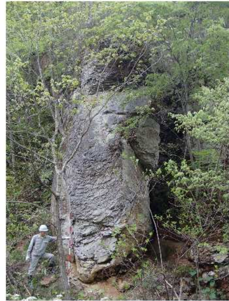
不安定な浮石
