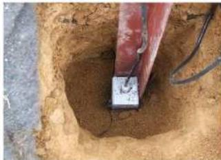
地表面下50cmを掘削し、長さ1mの鉄製アングルをさらに50cm打設固定しセンサーを固定設置
