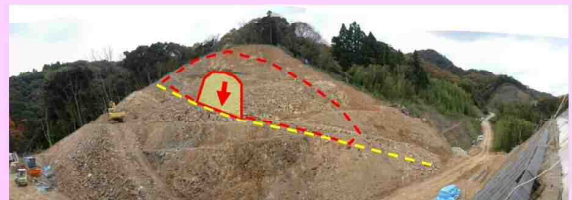
写真-1 現場の全景
