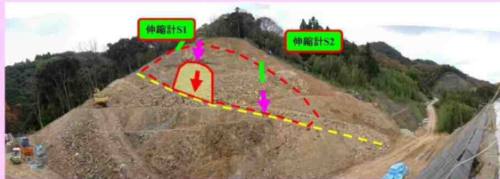
写真-1 現場の全景
