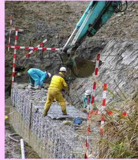
別の災害復旧現場の作業状況(新潟県中越地震直後)
