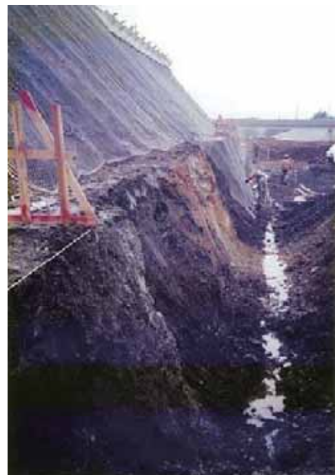
法面での全網張付け作業の状況
