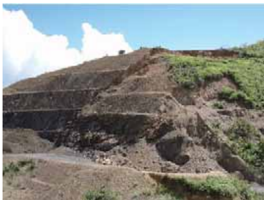
岩盤法面の割れ目沿いの大規模な滑動
