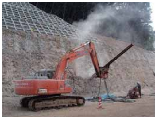
法面でのロックボルトの打設状況
