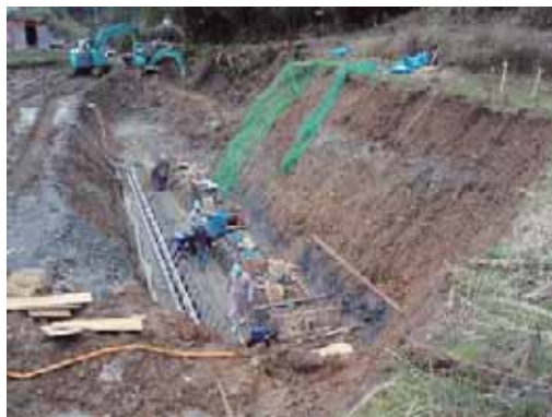
ブロック積擁壁の基礎部の施工状況
