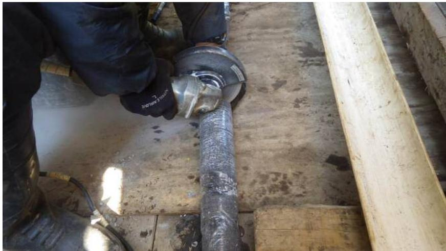
**写真10-2 ボーリングコアの切断状況**
