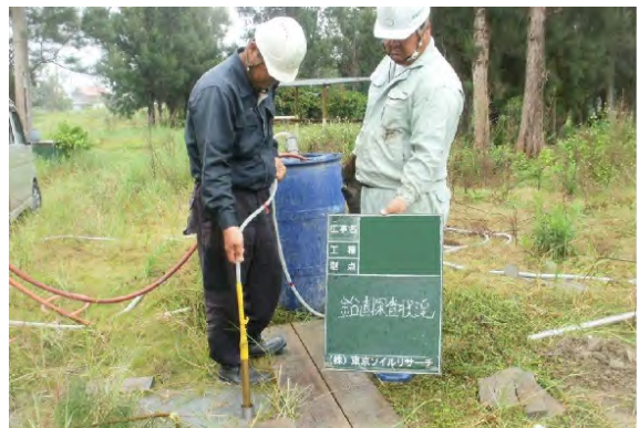
写真-2 鉛直探査状況
