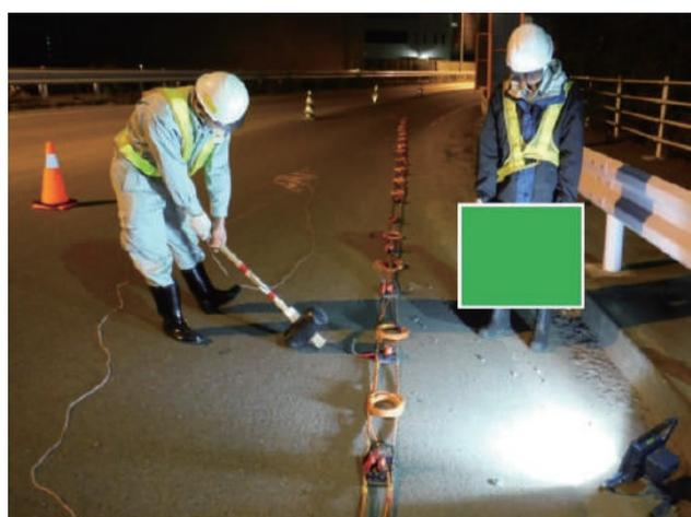
写真3 表面波探査実施例（夜間測定）
