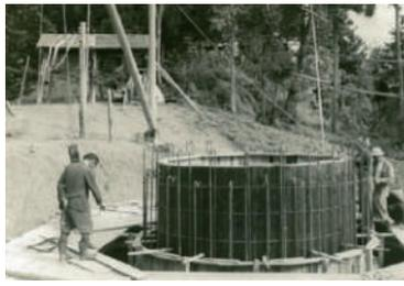
写真3 昭和30年(1955) 栃ヶ原地すべり。鉄筋・型枠を組みコンクリートを打設する
