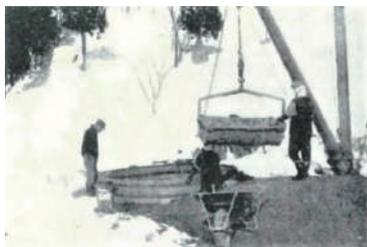
写真4 昭和37年(1962) 猿供養寺地すべり 内径3m、深19m、コルゲートによる試験施工<sup>8)</sup>。
