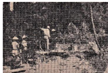
写真2 昭和24年(1949)種芋原地すべりの横孔ボーリング工試験施工<sup>5)</sup>
