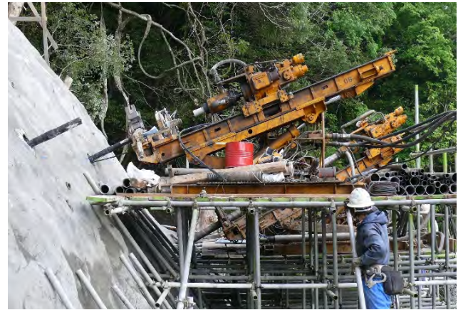
写真-4 斜面のアンカー工
