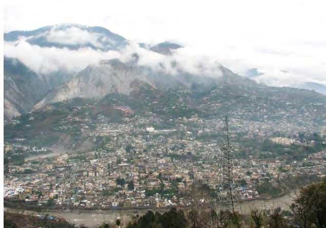
写真-6 2005年カシミール地震によって被災した州都ムザファラバード
