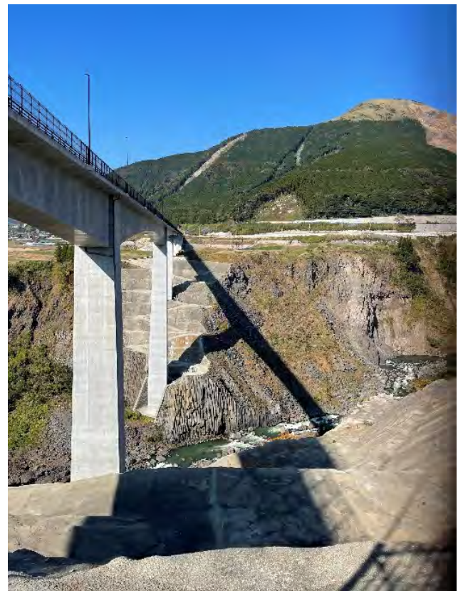
写真-5 復旧した阿蘇大橋。橋の左奥から右手前に断層が通過している。
