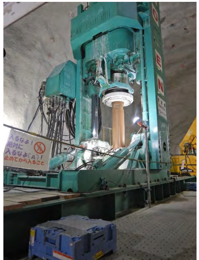
写真-8 ハイパーカミオカンデ空洞掘削状況
