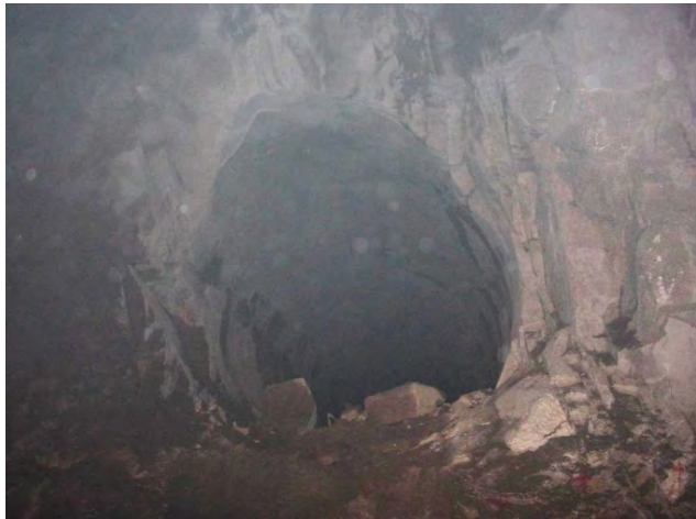
写真-3 第2名神高速道路建設の様子 TBMで掘削されたトンネル
