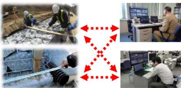
図 13 カメラを用いた遠隔臨場・遠隔立会検査 (情報提供：(株)環境風土テクノ、(株)堀口組、(株)愛亀)
