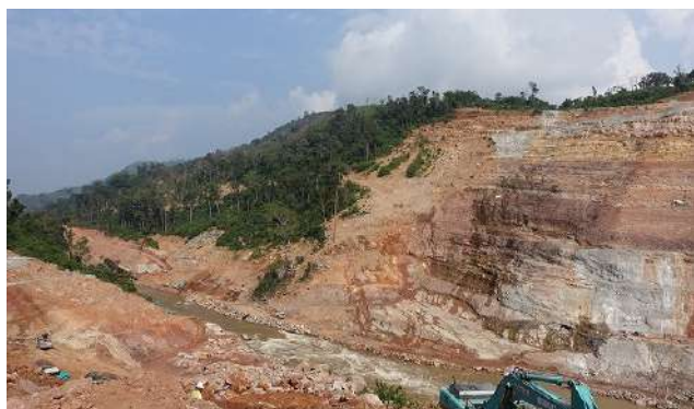
写真-10 転流前のダム軸，右岸から左岸上流方向を望む (2015年10月撮影)
