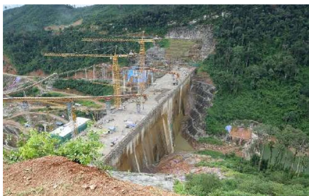
写真-11 本体打設中，左岸上流より望む。NNP1はRCC(Roller Compacted Concrete)ダム (2017年9月撮影)
