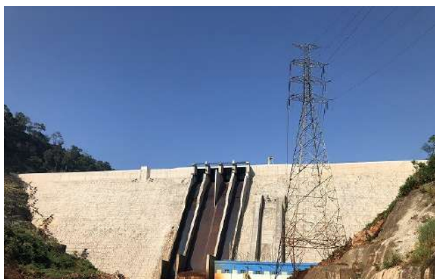
写真-12 本体完成後，ダム高167m，堤長530m (2019年11月撮影)
