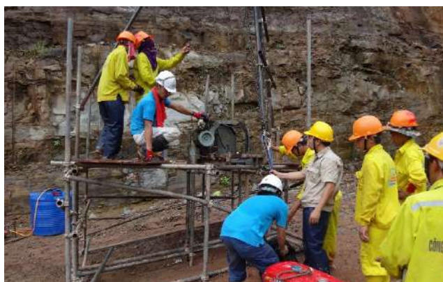
写真-8 SongDa5 作業員 (世話役1人, 作業員6人) と、人力で運搬・足場仮設を行いました。
