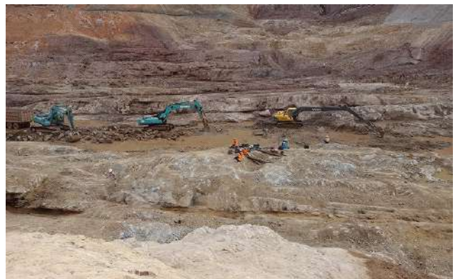
写真-7 掘削作業中の重機の横で、足場仮設を行います。ピックアップトラックが横まで乗り込めない場合は、人力での運搬となります。
