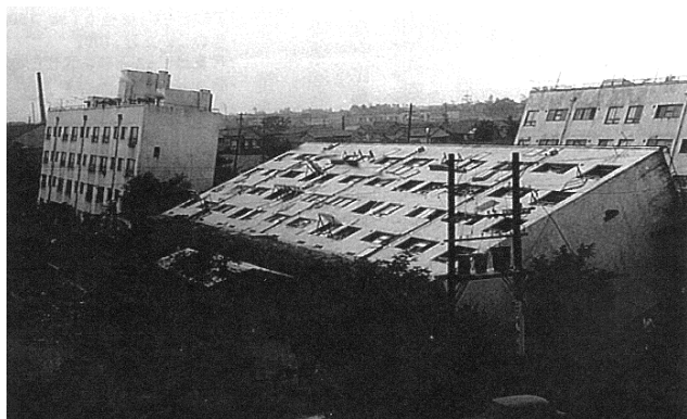
図-1 新潟地震の液状化で転倒した建物(1964年6月 1) )
