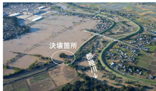
写真1 東松山市早俣地区の浸水状況
