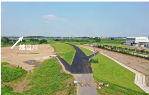
写真3 川越市平塚新田地先における本復旧状況
