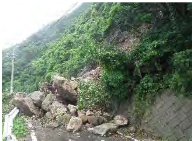
写真2 谷山地区土砂崩落状況 落石として2m程度の礫岩や安山岩の落石が多数認められ、崩落土砂が道路を封鎖していた。
