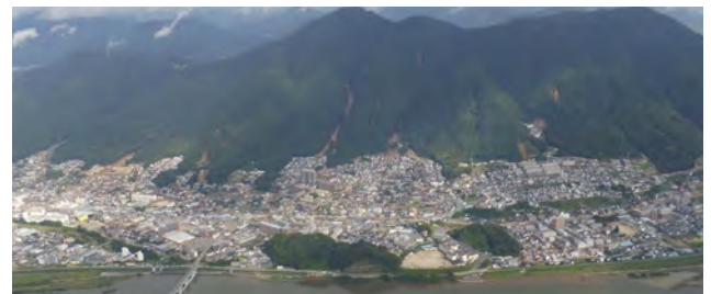
写真-2 平成26年8.20災害の際に広島市安佐南区阿武山麓を襲った土石流等の状況 (平成26年8月21日筆者撮影)
