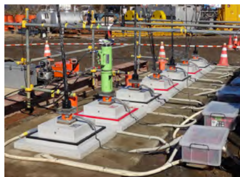
写真6 グラウンドアンカーの増打ち実大実験の様子 9)
