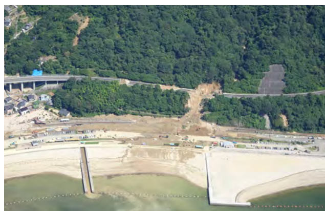
写真-4 平成30年7月豪雨が止んだ翌日8日に谷地形部を横断する道路盛土部分での崩壊 （広島県坂町水尻地区有料道路アクアライン上空から平成30年7月10日筆者撮影）
