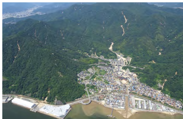
写真-3 平成 30 年 7 月豪雨による崩壊・土石流等で被災した広島県坂町小屋浦地区の状況 (平成 30 年 7 月 10 日筆者撮影)
