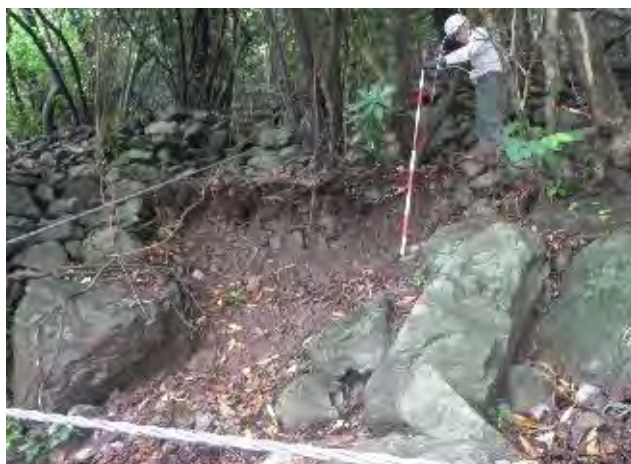
写真3 谷山地区滑落崖状況 滑落斜面には安山岩岩塊を転石状に混入する岩塊玉石混り土が認められる。
