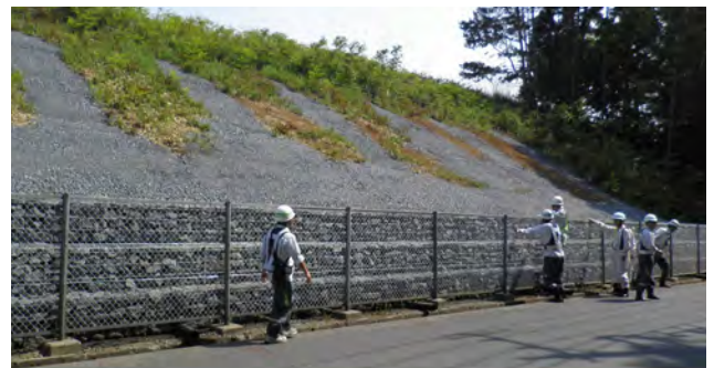
写真4 碎石豎排水工の施工完了状況 5)
