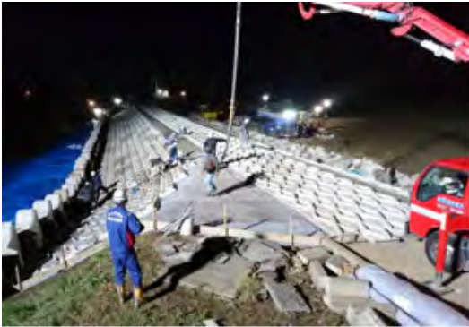
写真2 川越市平塚新田地先における緊急復旧状況
