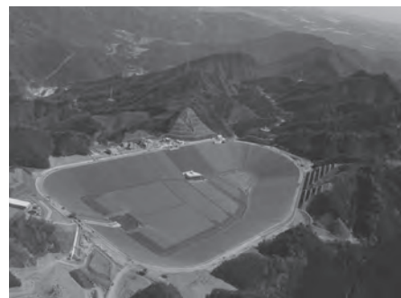
揚水発電用ダム, 宮崎県木城町
