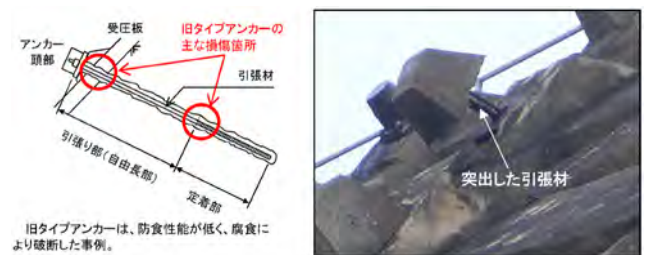
図3 切土のり面のグラウンドアンカーの変状 2)
