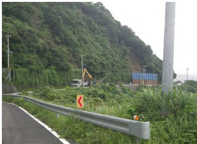
写真4 谷山地区仮設対策工実施状況 仮設防護柵を設置し、対策工が実施された。
