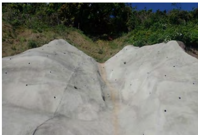
写真10 片浦地区の対策実施状況 崩壊斜面をモルタル吹付で保護。
