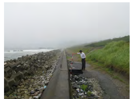
図-5 捨て石と消波ブロックで防護された侵食域の状況(地点3)
