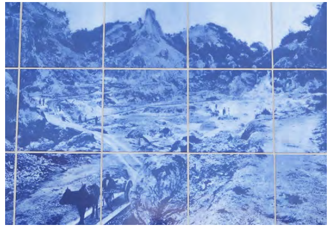
写真 4 大正～昭和の露点掘り（現地設置陶板より）
