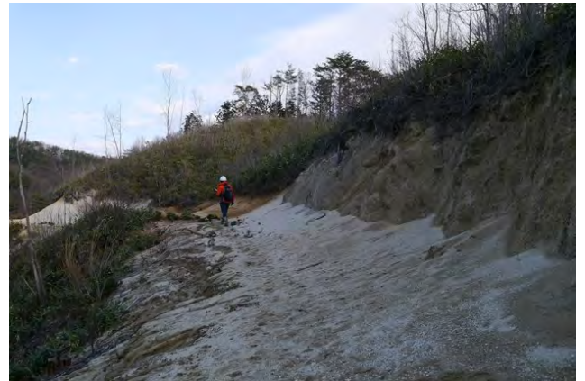
写真1 法面崩壊が進むマサ土地帯の作業道
