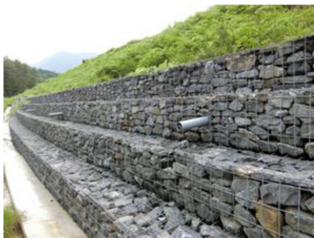
図-4 かご枠工を併用した水抜きボーリング
