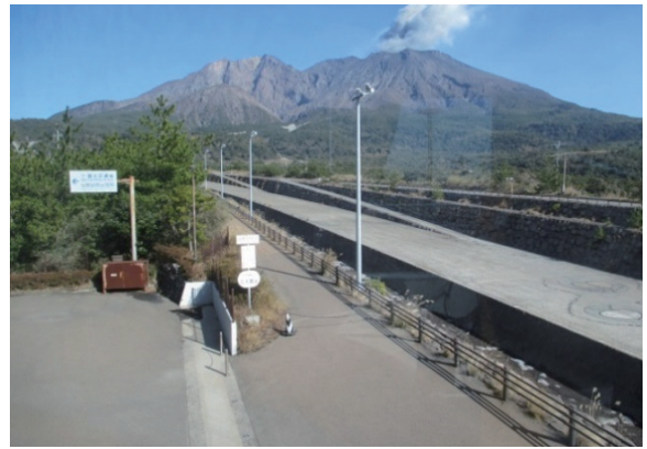
館内から見る野尻川の砂防施設
