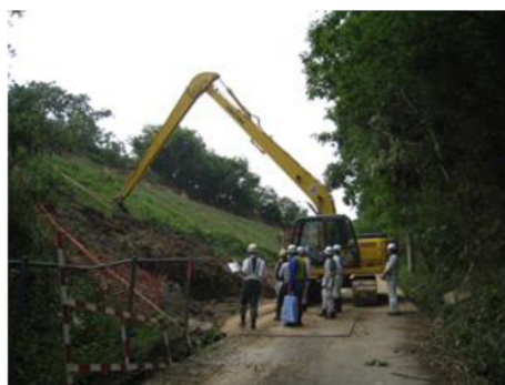
図-7 砕石スリットの施工状況
