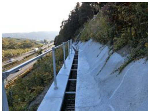
図-20 排水施設の対策状況
