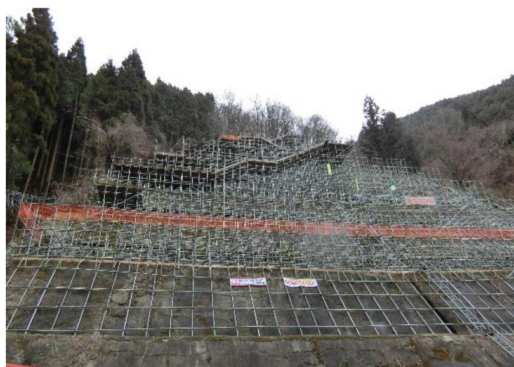
図-19 米子自動車道の工事状況 12)
