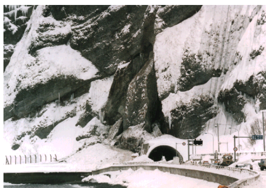
写真1 岩盤崩落事故(豊浜トンネル) 建設グラフィックネットワークダイジェスト より http://www.jiti.co.jp/graph/toku/toyohama/toyohama.htm
