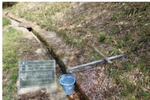
図-12 水抜きパイプの排水状況 8)
