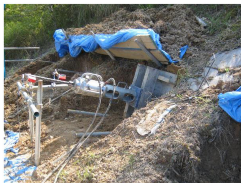
図-14 引抜き試験の状況 9)
