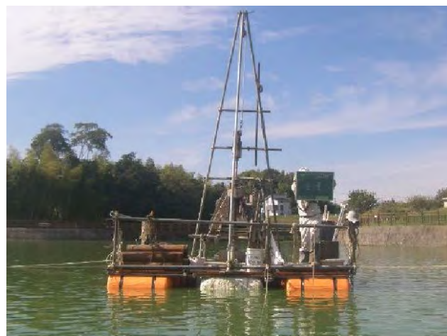
Ph-1. フロート台船による水上足場状況
