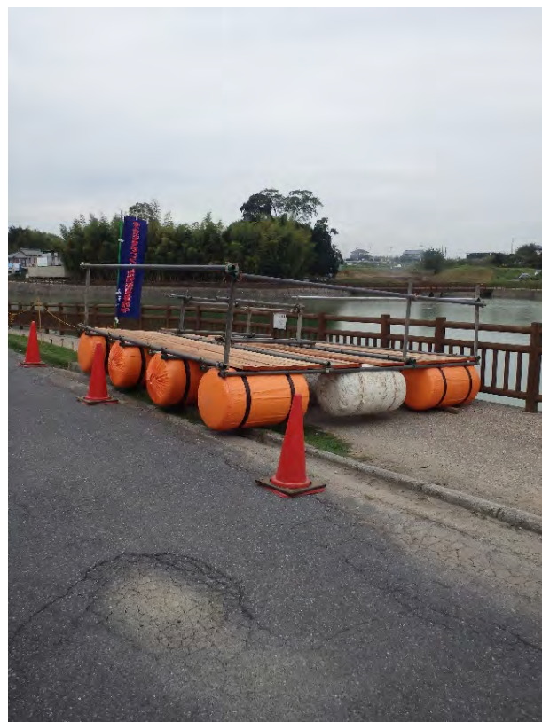
③矢板をフロート上に敷き、フロート台船を完成させる。
