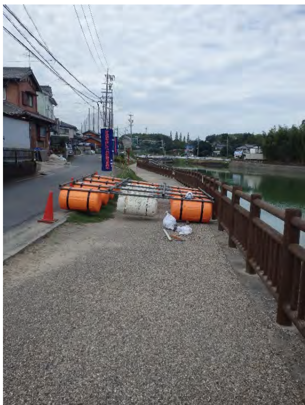
②単管パイプにスチロパール（発泡スチロール）を取り付ける。
