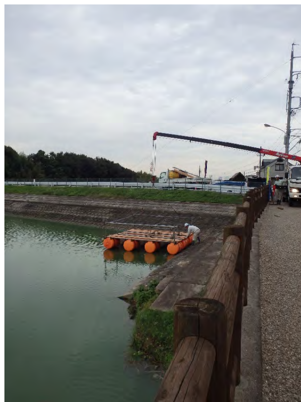
④フロート台船をユニック等で水面に降ろす。
