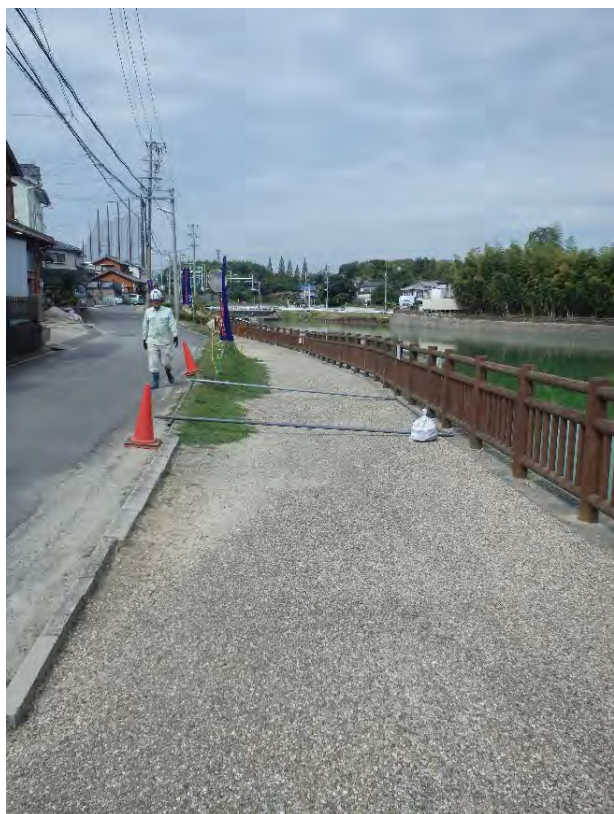
①単管パイプ (L=4m × 3.5m) でフロート台船の型枠を作成する。
