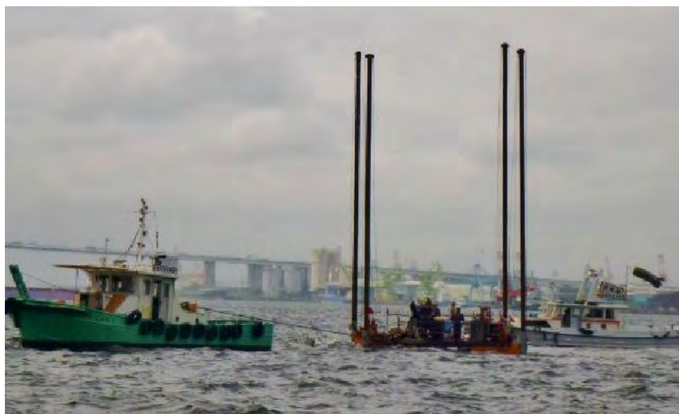
Ph-3. スバット台船の曳航状況
