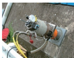
(d) SAAM ジャッキ設置
