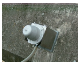
(f) 設置完了
