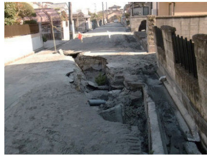
写真 1 いわき市植田町根小屋における液状化被害（いわき市提供）
