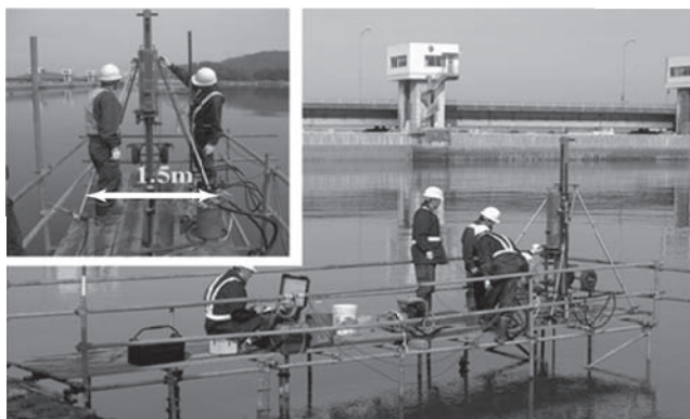
写真5 河川上での簡易足場を用いたPDC実施状況
