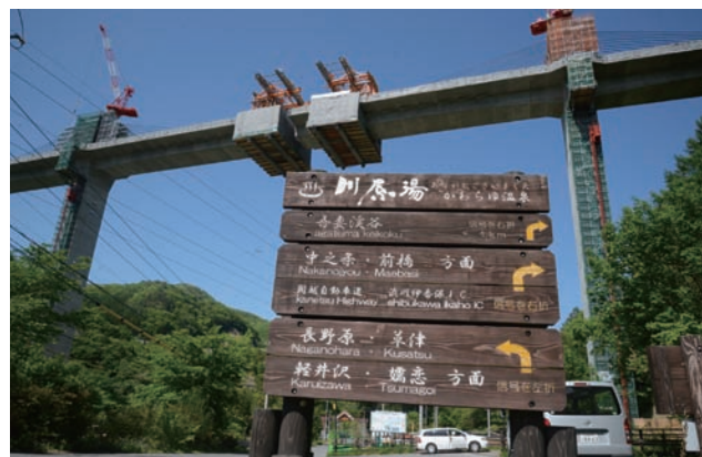
写真4 川原湯温泉の上空は架橋中
