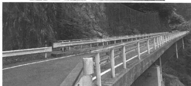
図12 約10年が経過した現在の現場状況
