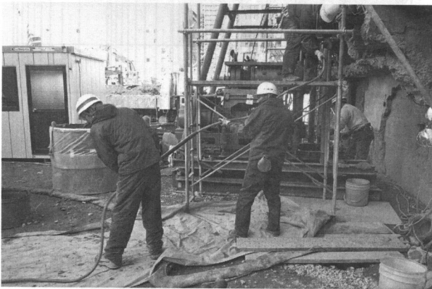
写真4 ボーリングロッド（二重管）の継ぎ足し状況
