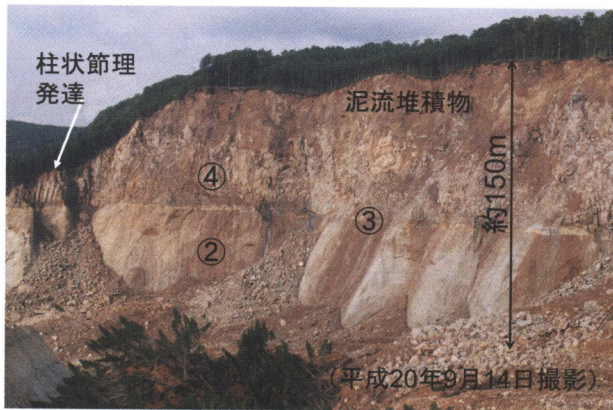
写真2 旧道切断地点 (A) より西方を望む
