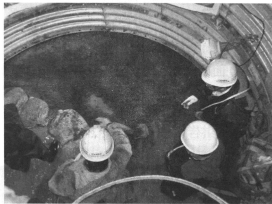
写真4 施工中の集水井内部の状況
