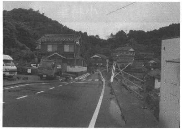
写真1 被災時の地すべり頭部
