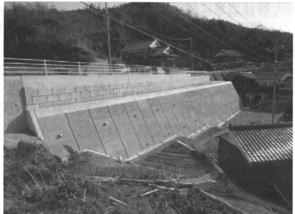
写真4 対策工（アンカー付き気泡混合軽量盛土工）
