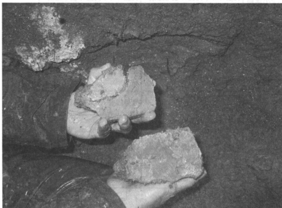
写真11 凝灰岩を伴う主すべり面（A集水井）
