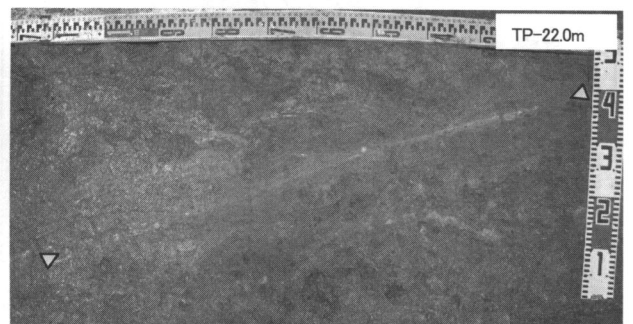
写真8 泥岩中のすべり面 (C集水井)
