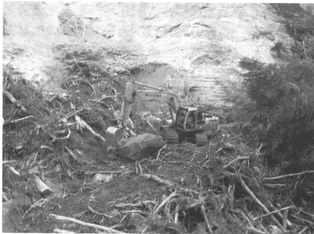
写真2 応急対策班（無人化施工機械）
