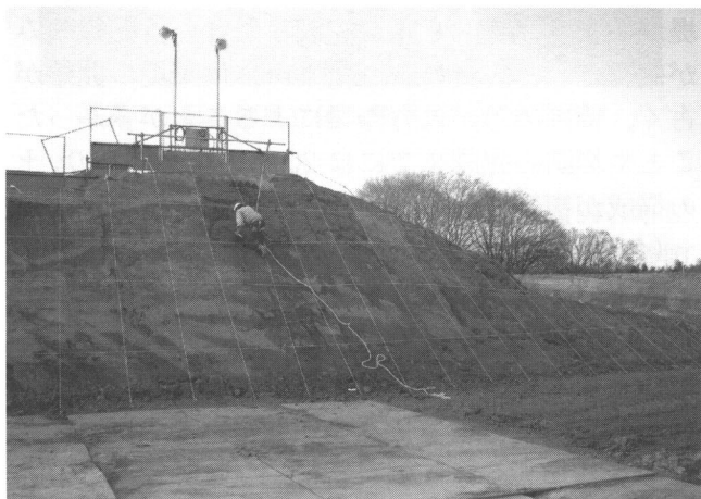
写真1 断面観察の状況写真
