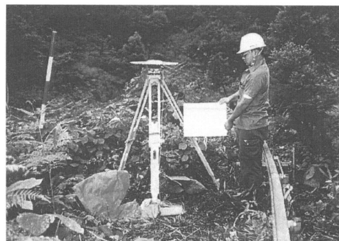
写真1 地すべりでのGPSによる移動杭測量
