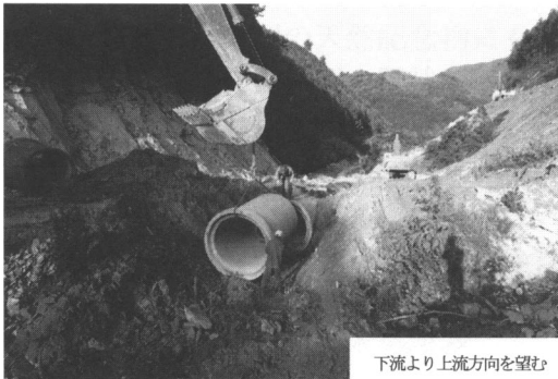
写真2 谷底排水管敷設工事資料
