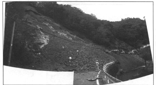
写真 1 崩壊法面全景写真
