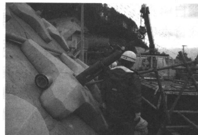
(a) センターホール型ジャッキによるリフトオフ試験状況
