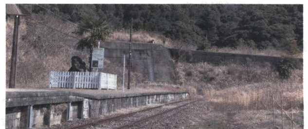
写真4 ホーム奥の「山津波記念石」と砂防堰堤
