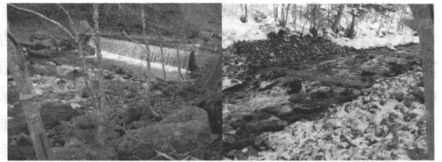
図2 イワウベツ川支流赤イ川治山ダムの改良状況(北海道森林管理局提供)
