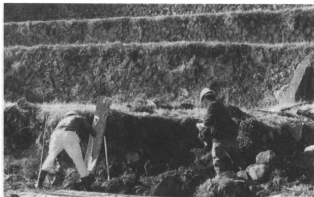
写真 14 石積みの修復
