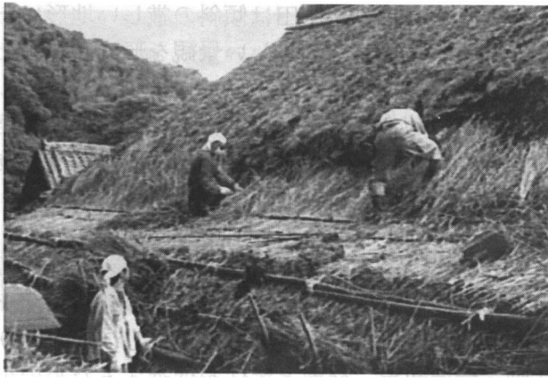
写真9 茅葺屋根の補修
