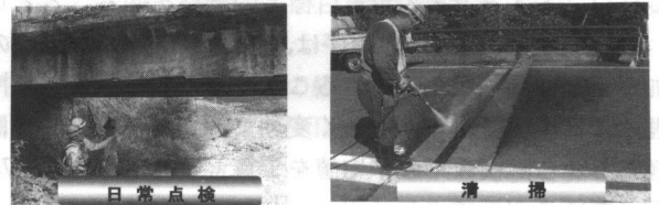
図13 橋梁維持工事(包括発注)
