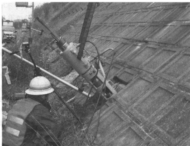
写真1 リフトオフ試験実施状況
