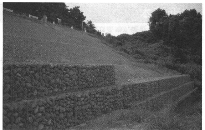
写真4 のり先に大型ふとんかごを設置してのり先の排水性を高めた事例
