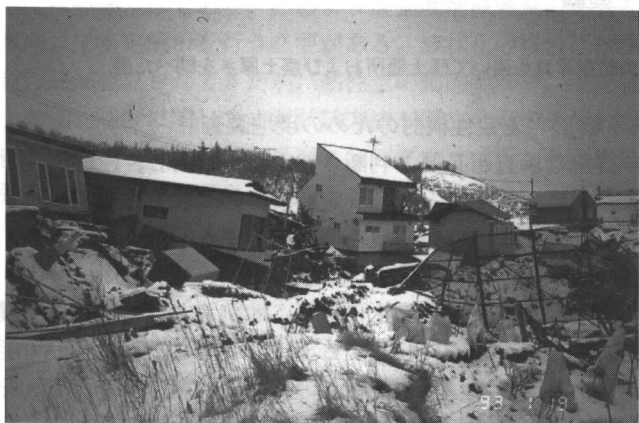
写真3 1993年釧路沖地震における茅沼の被災状況
