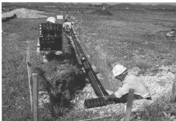
写真1 地下水排除工（暗渠排水工）
