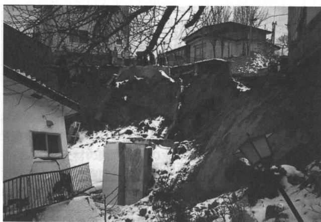
写真2 1993年釧路沖地震による釧路市緑が岡の被災状況
