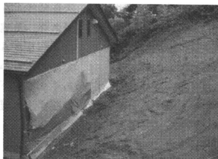
写真5 砂丘斜面の崩壊による住宅の外壁等の被害例
