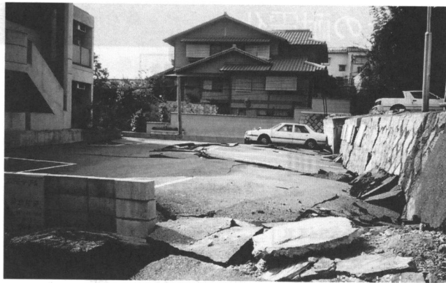
写真2 兵庫県南部地震における谷埋め盛土の地すべり (西宮市)。画面奥の民家と手前の道路の間 (駐車場の部分) はかつて、深さ5m程度の谷であった。この谷埋め盛土は、画面の200mほど右から左へ数m移動し、画面左のマンションに当たって停止した。駐車場には、末端部の隆起に伴うクラックの発達が顕著である。ここは、現在では住宅地として使われている。
