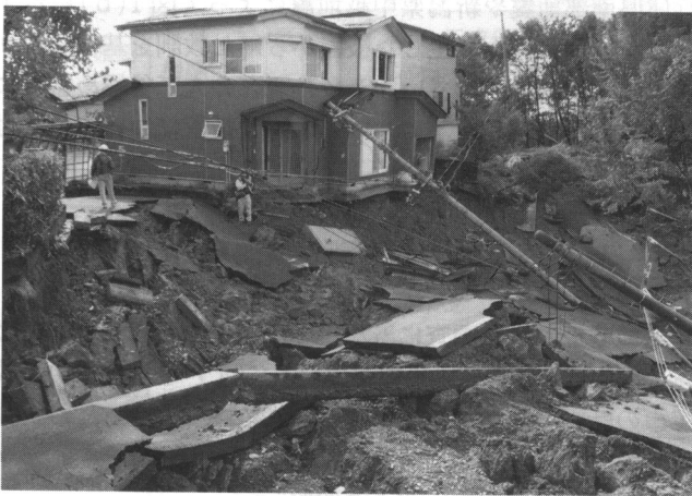
写真3 新潟県中越地震による長岡市高町団地の被害。崩壊した部分は、谷頭部の盛土である。
