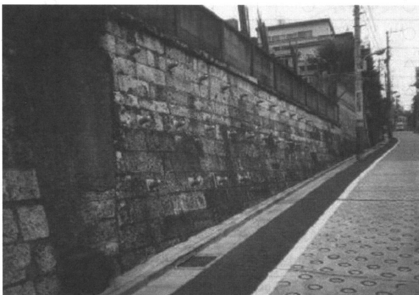
写真1 ネイリング工法による石積み壁の補強事例
