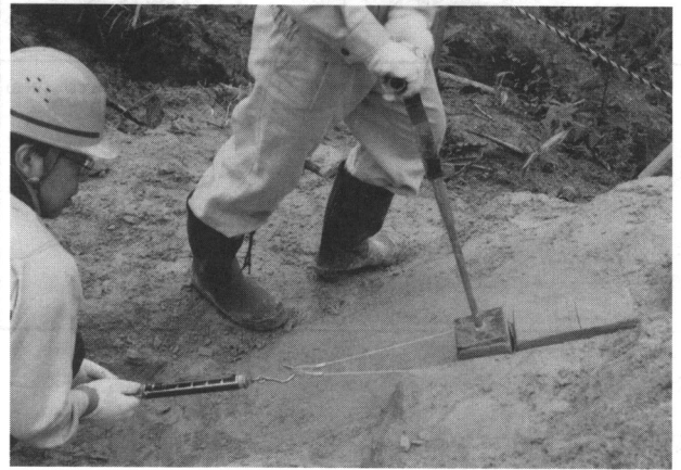
写真4 せん断試験状況
