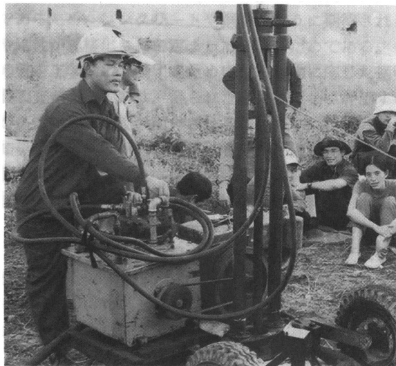
写真4 ベトナムでの電気式静的コーン貫入試験の様子。
