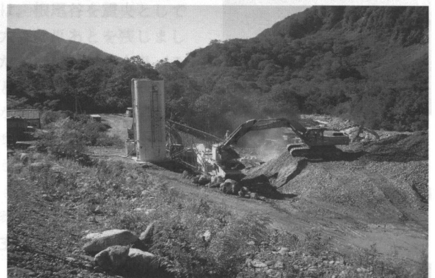
写真2 母材と改良材の攪拌状況
