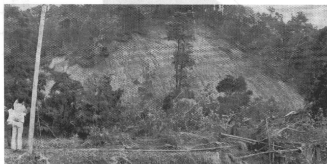
写真4 1971年千葉県豪雨災害で発生した崩壊(小見川町)。斜面上部が深くえぐれている。その基底に更新世の木下層群砂層に局部的にはさまれる粘土が位置している。写真は、千葉県(1972) 6) 。
