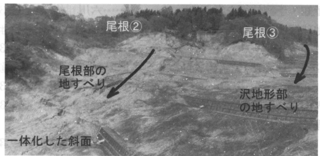
写真3 尾根部と沢地形部の地すべりが合流する例
