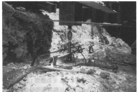
写真2 平板荷荷試験
