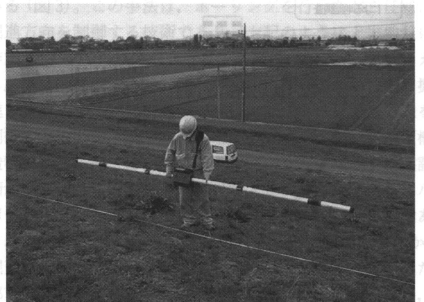
写真1 スリングラム式EM探査(浅深度タイプ)の作業状況
