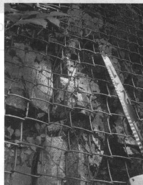
写真3 のり面Cで観察される地山および吹付剝落
