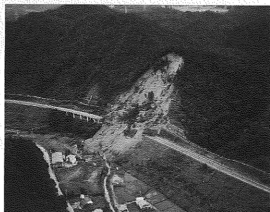
写真1 東海北陸自動車道の斜面崩壊 (Photo by JH)
