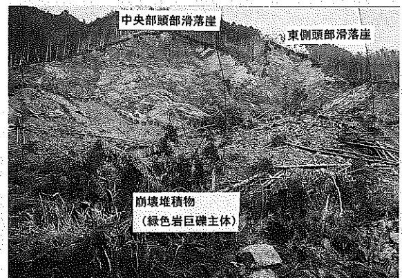
写真3 大用知崩壊頭部全景(倒木と崩壊土砂が下方に残存する)
