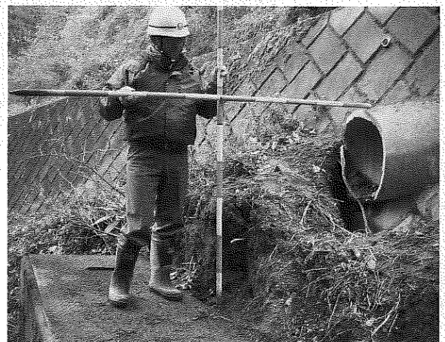
写真6 タイプ5-②現地状況
