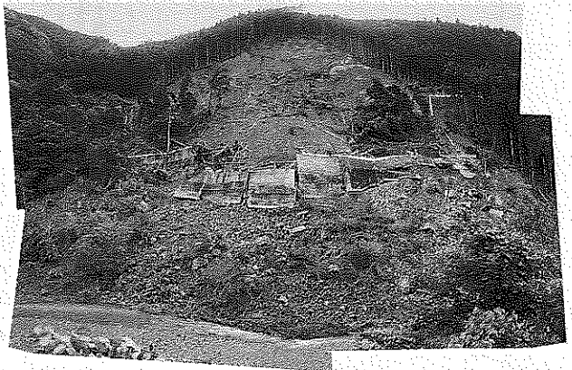
写真1 崩壊前後の全景比較
