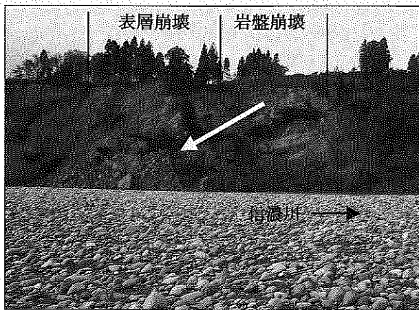
写真4 全景(信濃川右岸より撮影)
