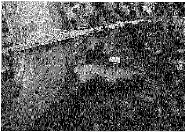
写真6 刈谷田川破堤箇所周辺状況 (H 16.7.14 撮影)
