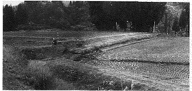
写真8 北西-南東方向に連続する段差・亀裂
