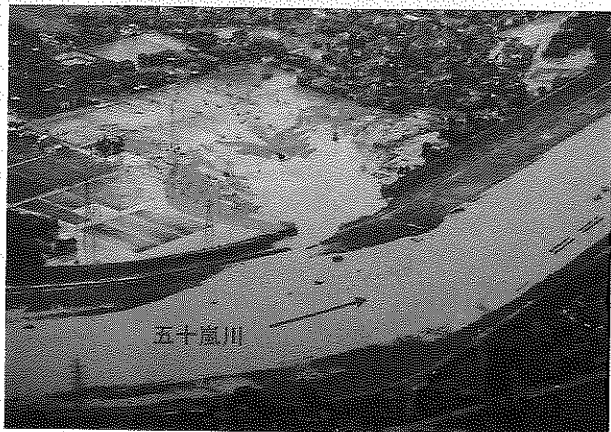
写真5 五十嵐川破堤箇所周辺状況 (H.16.7.14撮影)
