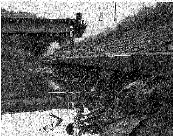
写真13 矢板(軽量矢板)護岸の傾倒状況(新潟県柏崎地域振興局提供)
