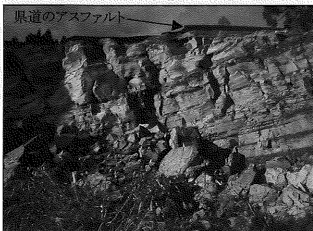
写真5 滑落崖に露出する川口層
