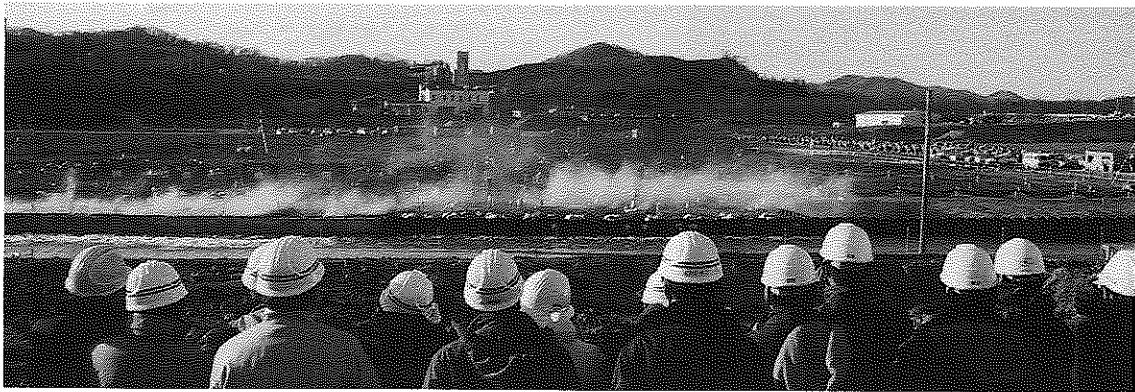
写真3 発破実験中の様子, 手前は見学者
