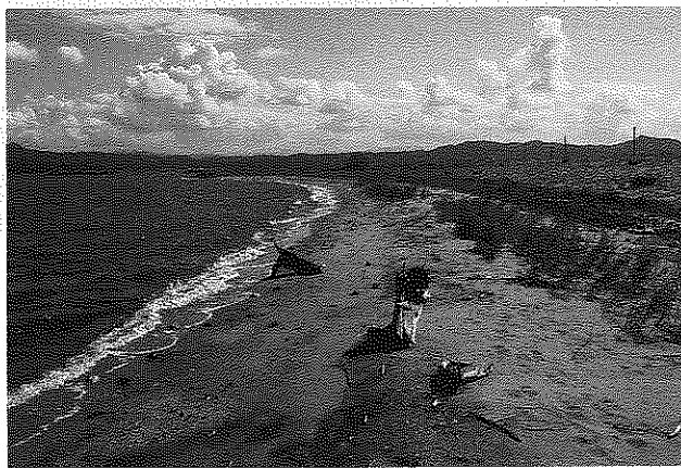
写真4 宍道湖，斐伊川河口左岸。施工後，斐伊川からの土砂供給もあり，より自然な形状に変化。
