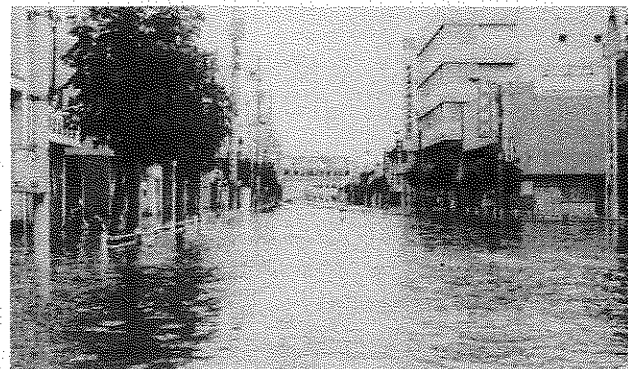
写真2 昭和47年 松江市浸水状況
