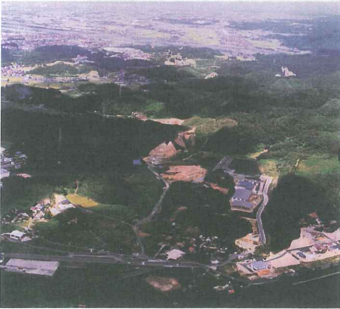
工事前 (平成 4 年 8 月撮影)
