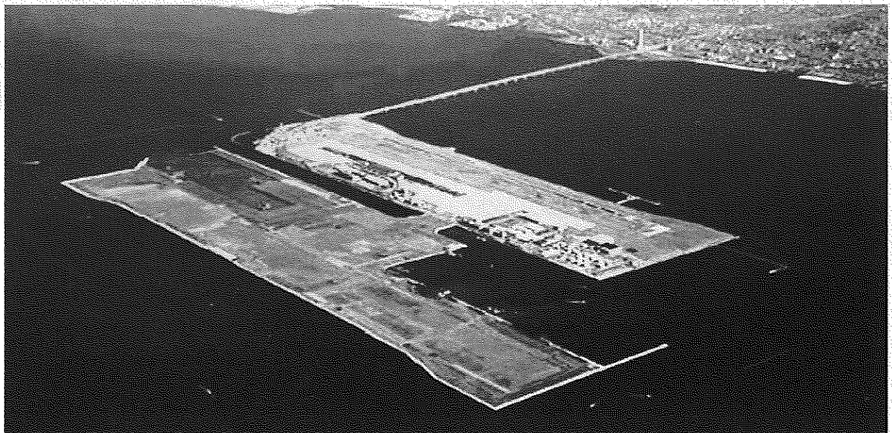
写真1 関西国際空港2期用地造成事業の現況(平成16年2月現在)
