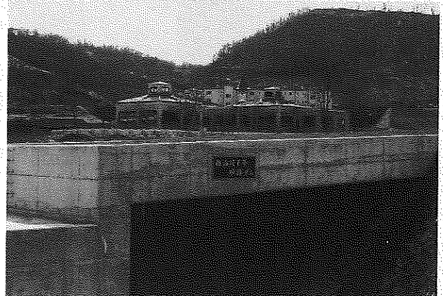
写真2 西山川砂防ダム (2004.4.7撮影)
