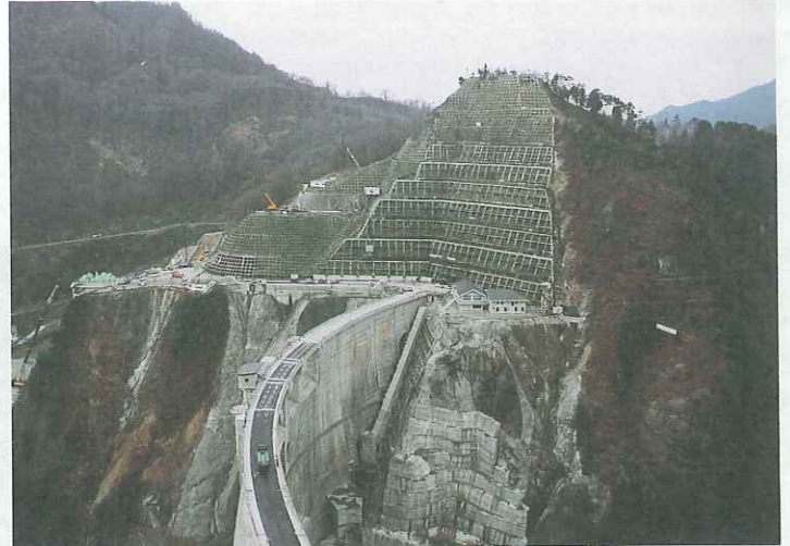
口絵5 本体コンクリート打設完了(右岸側からダム天端を望む)(新潟県土木部提供) [北陸]
