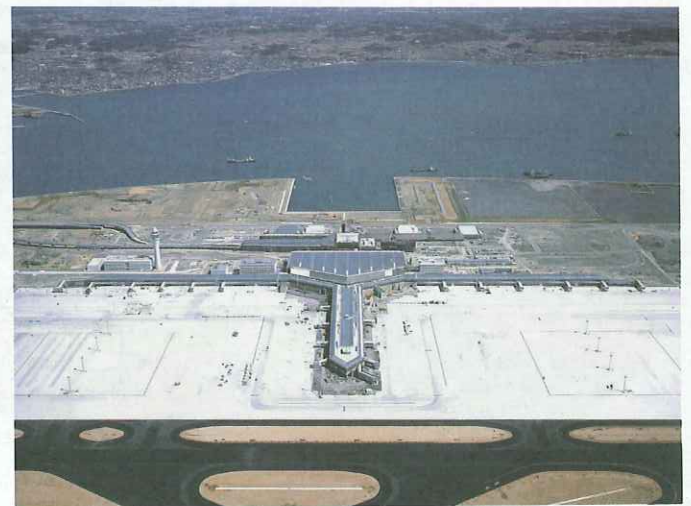
口絵9 ターミナルビル建設状況 (撮影平成16年3月)(中部国際空港(株)提供) [中部]
