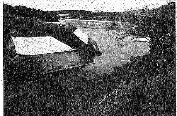
写真4 出現したカンジン地下ダムの湛水湖
