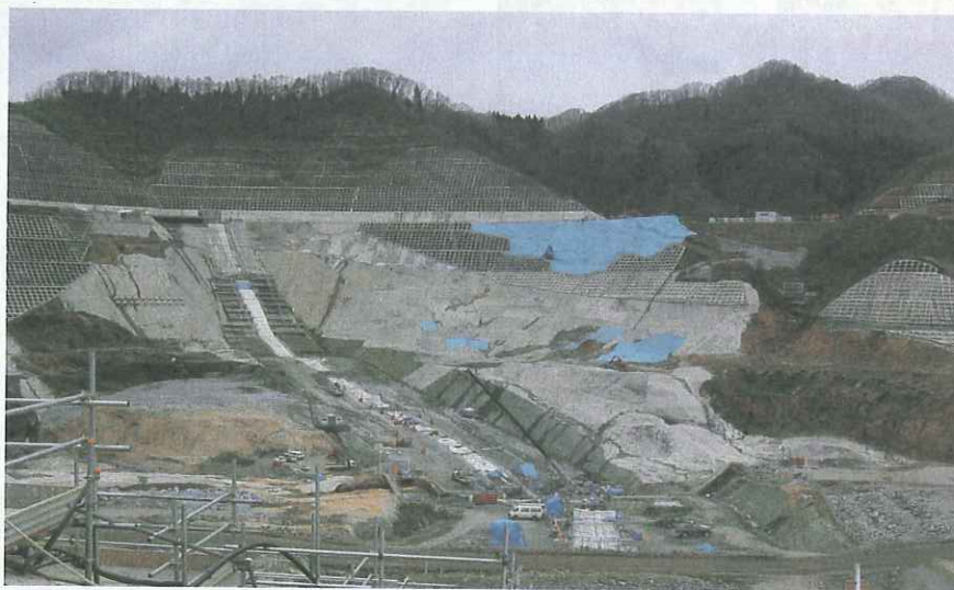
口絵 2 森吉山ダムサイト基礎掘削状況 (河床部および右岸側) [東北]
