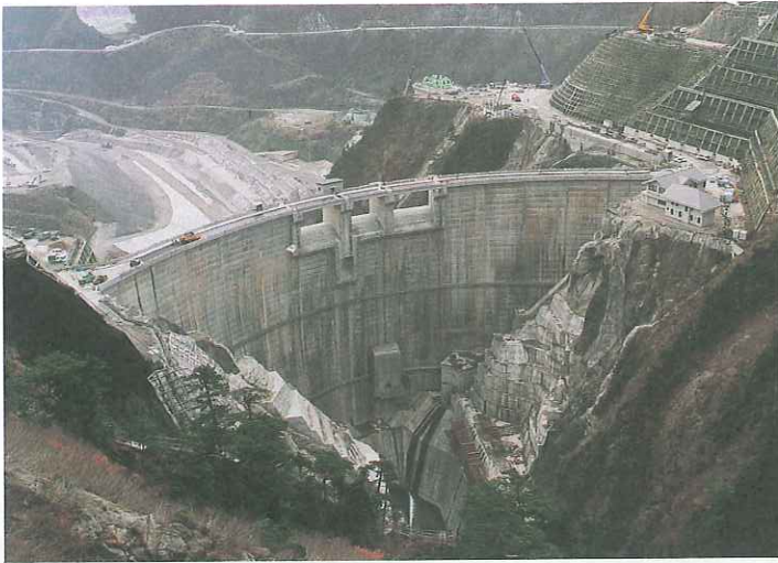
口絵4 本体コンクリート打設完了(下流面)(新潟県土木部提供) [北陸]
