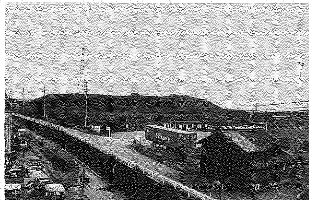
写真1 建設廃棄物の山(後方)
