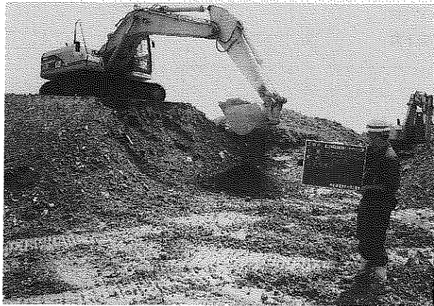
写真4 スケルトンバケットによる施工状況
