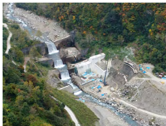
図-3 水谷第3号砂防堰堤補強対策
