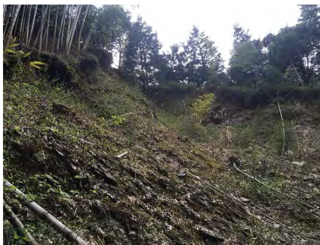
写真9 街道を途絶えさせる表層崩壊
