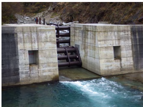
図-6 妙寿砂防堰堤 (シャッター)
