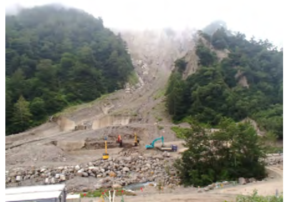
図-5 有峰二の谷の無人化施工
