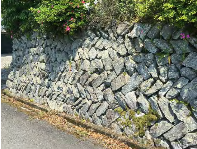
写真3 片理面に沿って割られた「へぎ石」で築かれた石垣
