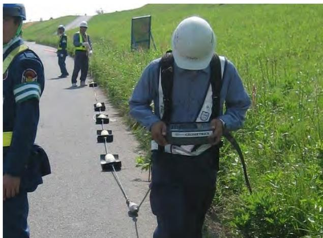
写真2 牽引式電気探査
