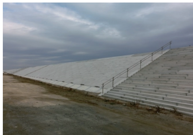
図-14 防潮堤裏法面の張ブロック
