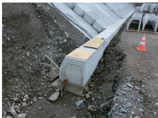
図-13 防潮堤裏法尻の洗掘防止用矢板
