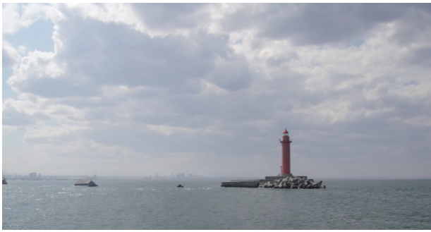
図-16 八戸港北防波堤ハネ部の被災状況
