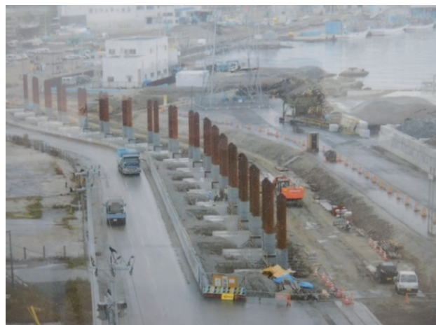
図-12 ハイブリッド防潮堤の施工状況
