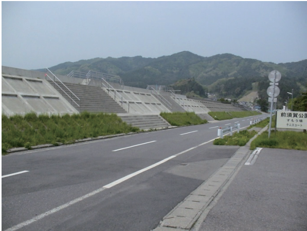
図-1 田老町に建設された防潮堤
