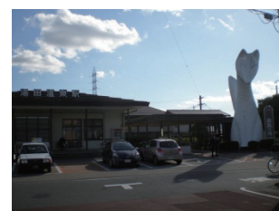
写真-3 駅舎全景
